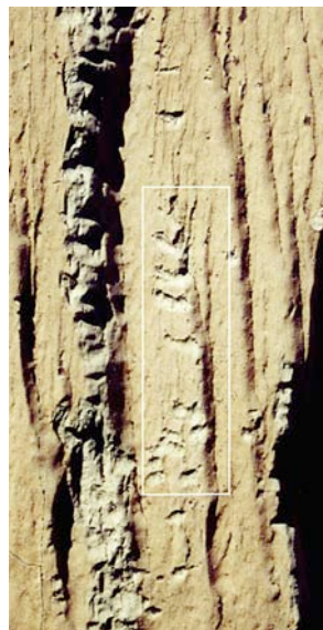
Fig. 8 - Détail des traces accidentelles.
