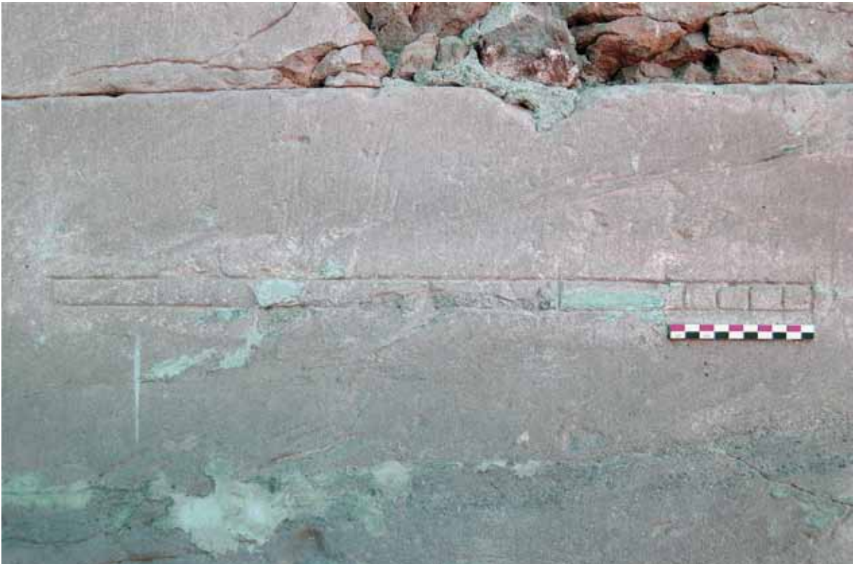
FIG. 7. Graffito d'une colonne reformée sur la face ouest du môle nord du pylône. BIFAO 116 (2014), p. 589-606. Pierre Ziviani L'architecture du temple de Montou à Ermant. Essai d'approche typologique et proportion du plan © IFAO 2020 BIFAO en ligne https://www.ifao.egnet.net
