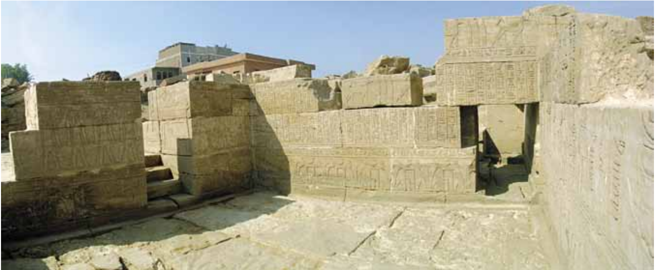
FIG. 11. Crypte de caisson sous l'espace (F5), avec à gauche l'escalier d'accès dans l'épaisseur du mur ouest et à droite, l'ouverture sur la crypte d'épaisseur du mur nord.
