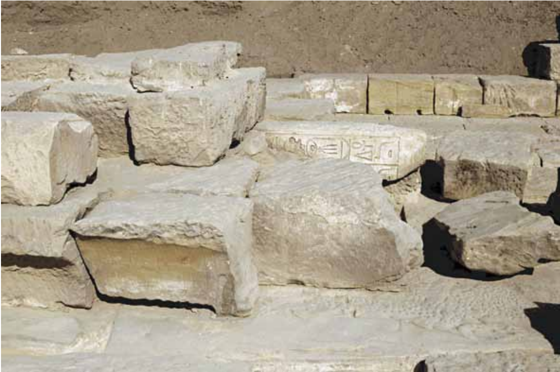
FIG. 14. Détail de l'appareillage des blocs de réemploi dans la plate-forme du pronaos .
