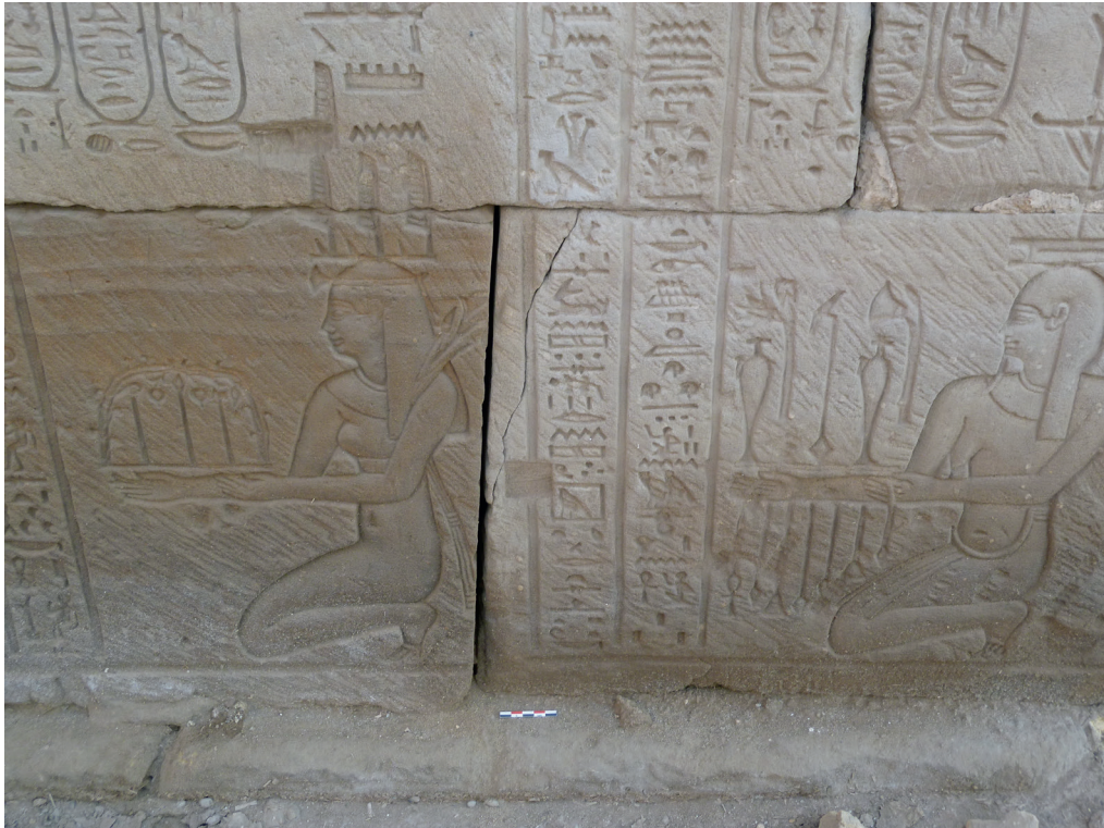
Fig. 12. Karnak, temple d'Opet, façade nord, détail d'un repère de ravalement dans l'épigraphie. Remarquer la ciselure périmétrale trop profonde du joint supérieur du même bloc.
