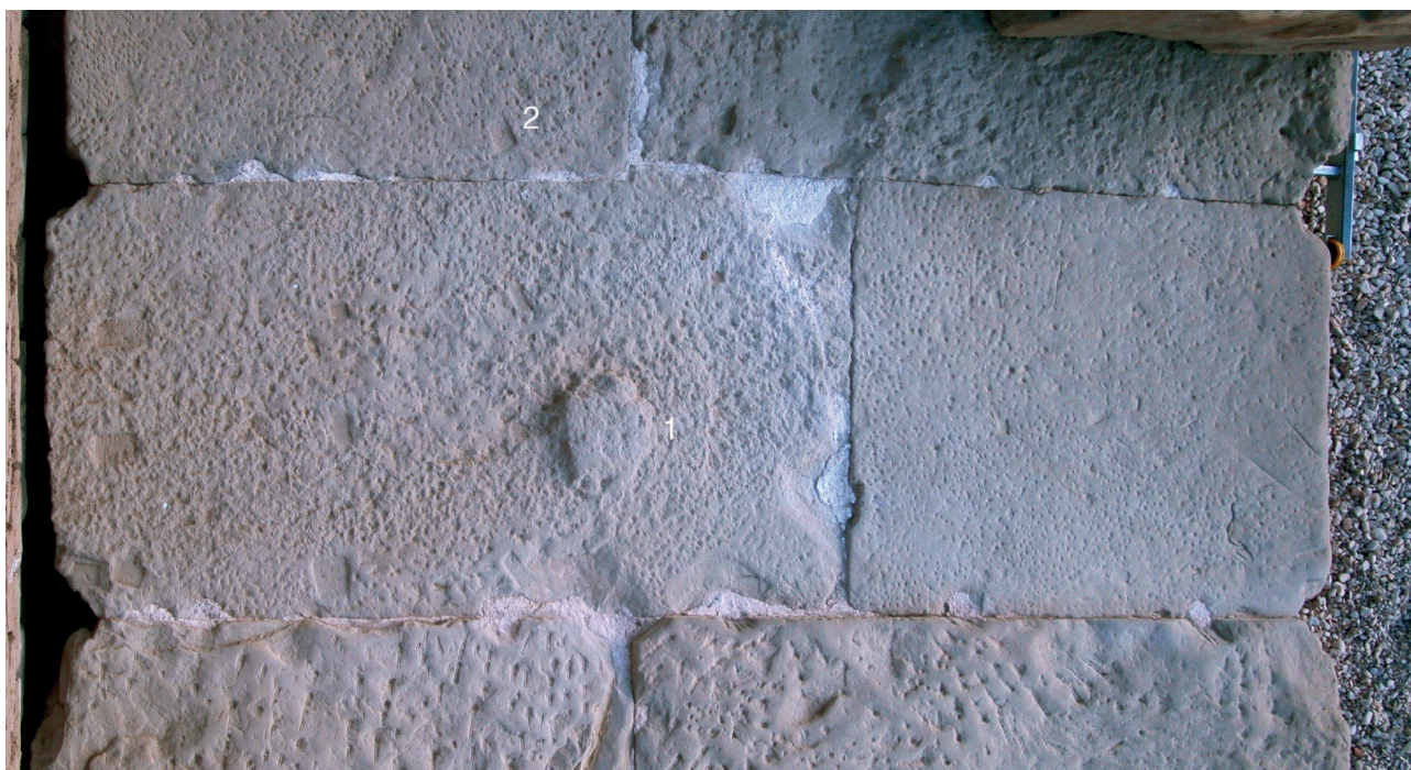
Fig. 27. Dendara, temple d'Hathor, détail de la fig. 26, bloc avec repères, à la limite de la préparation du lit d'attente. Remarquer : en (1) le témoin de la surface précédent le dégrossissage en cours ; en (2) un repère sur la pierre voisine.
