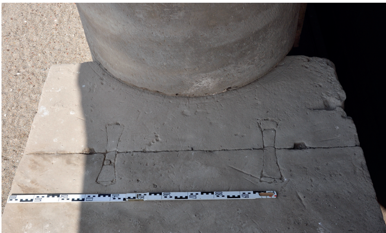
Fig. 21. Dendara, mammisi « romain », détail de la géométrie directrice des chapiteaux sur les murs d'entrecolonnement.
