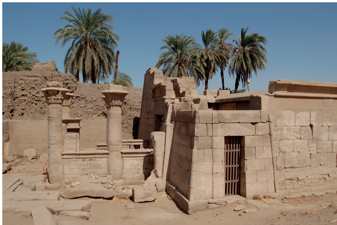
Fig. 10. Karnak, temple de Ptah, vue depuis le sud de la rénovation ptolémaïque (Ptolémée III) du côté occidental de la cour du sanctuaire.
