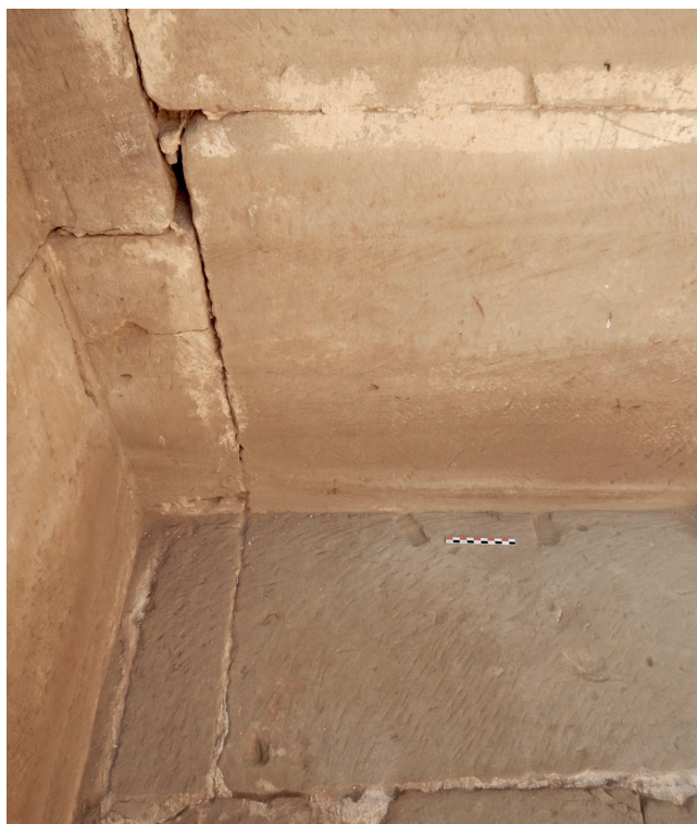
Fig. 22. Dendara, mammisi « romain » crypte D (numérotation Piéron), détail des repères de « ravalement » sur le sol au pied de l'élévation sud.
