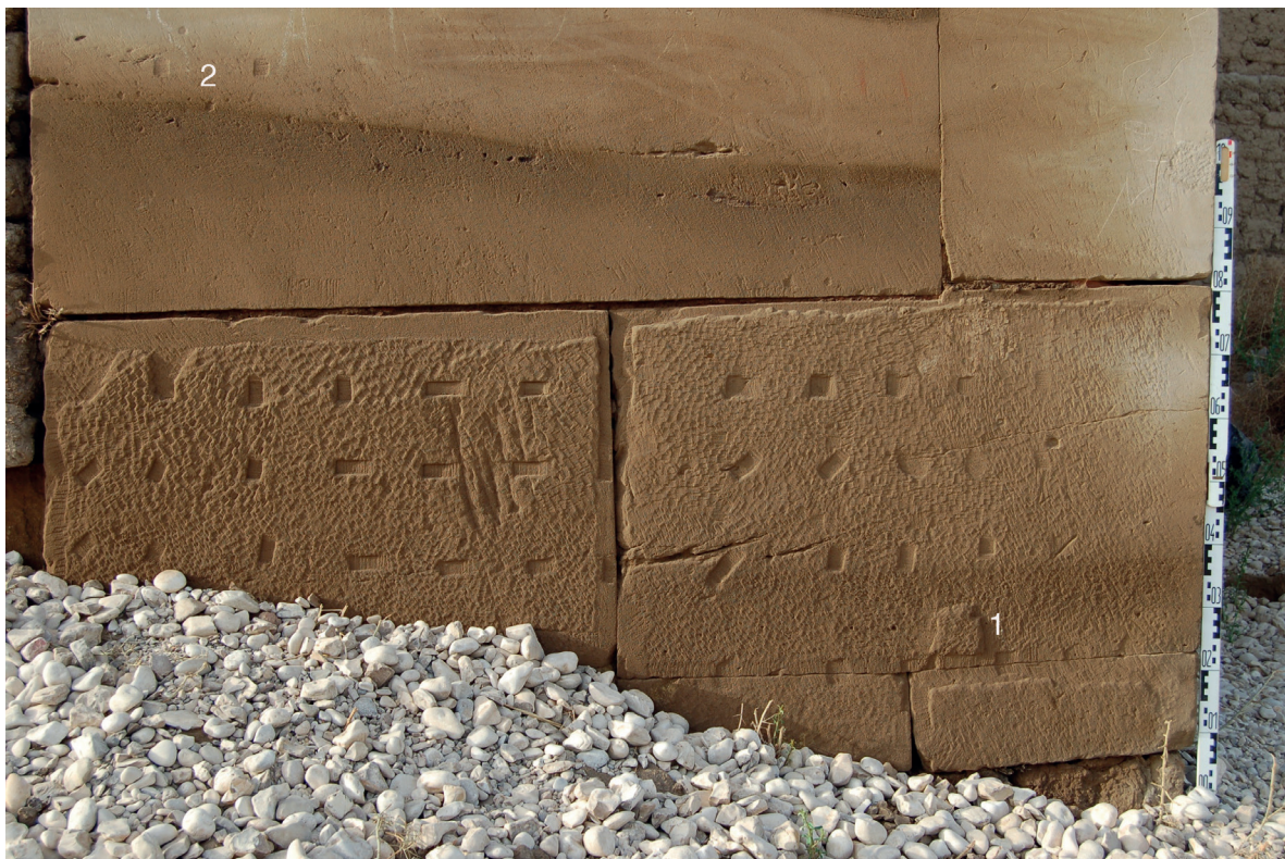
Fig. 8. Dendara, porte nord d'accès dans le téménos, pied de l'extrémité du massif occidental. Remarquer : en (1) le témoin de la surface précédant le dégrossissage en cours ; en (2) des repères de ravalement trop profonds qui restent apparents dans le traitement final.
