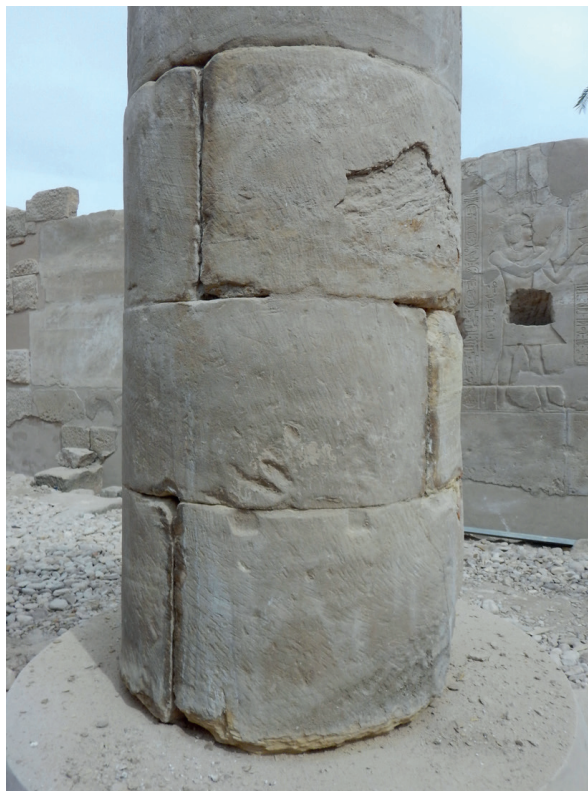
Fig. 19. Karnak, zone centrale, « magasin nord » 2 (MNT 2), détail des repères de ravalement sur le premier tambour de la colonne occidentale (cliché Chr. Thiers).
