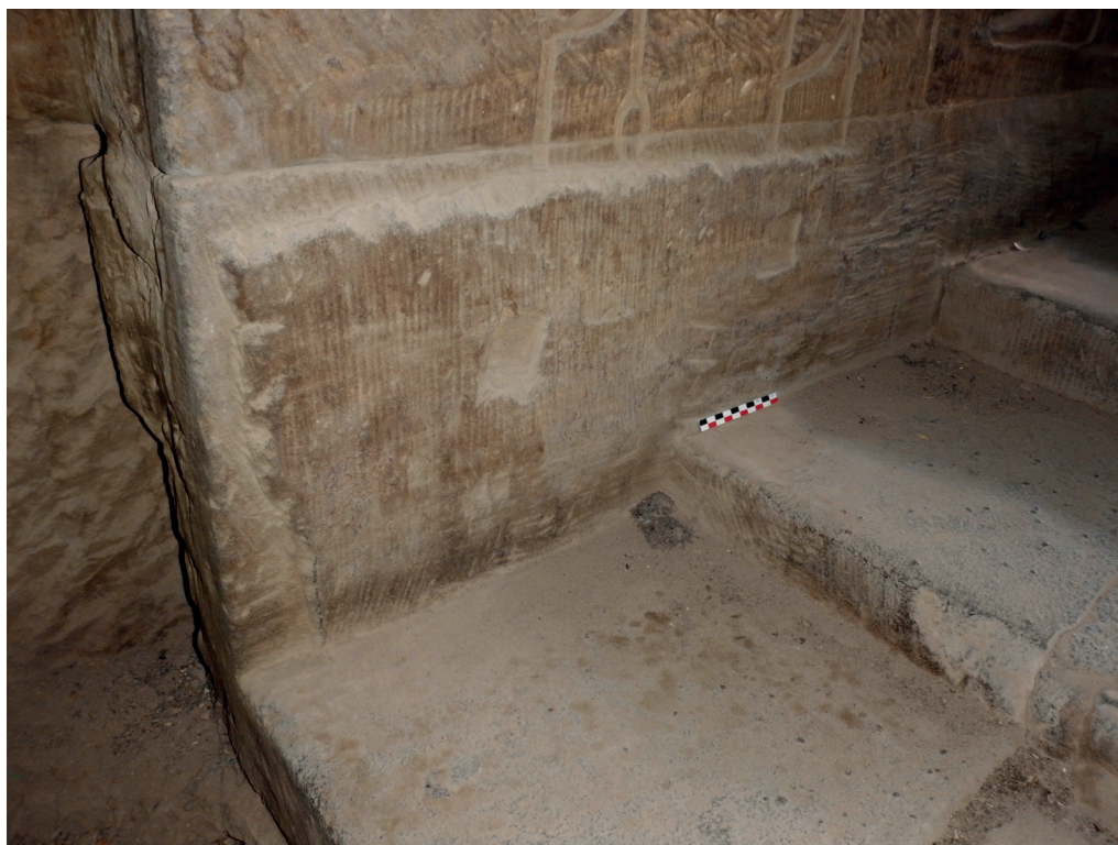
Fig. 16. Edfou, temple d'Horus, bas de l'escalier longitudinal ; côté ouest, détail du bas de la paroi avec son ravalement inachevé et deux repères dans la surface en partie démaigrie.
