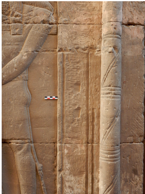
Fig. 4. Dendara, mammisi « romain », portique sud, détail de repères de ravèlement dans le second mur d'entrecolonnement.
