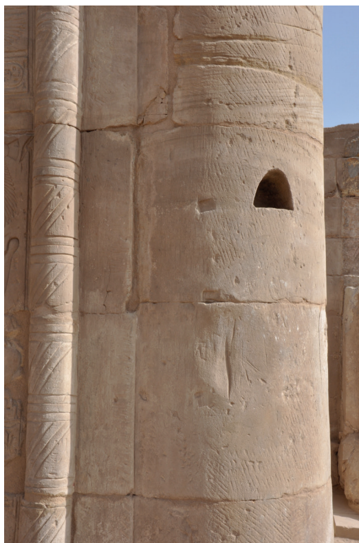
Fig. 17. Karnak, temple de Ptah, kiosque de la rénovation de Ptolémée III, détails de repères de ravèlement apparents sur la surface finie du fût (colonne sud-ouest).
