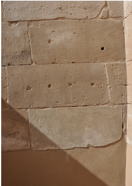
Fig. 11. Karnak, temple de Ptah, salle sud de la rénovation de Ptolémée III, détails de repères de ravalement apparents sur la surface finie (paroi ouest).
