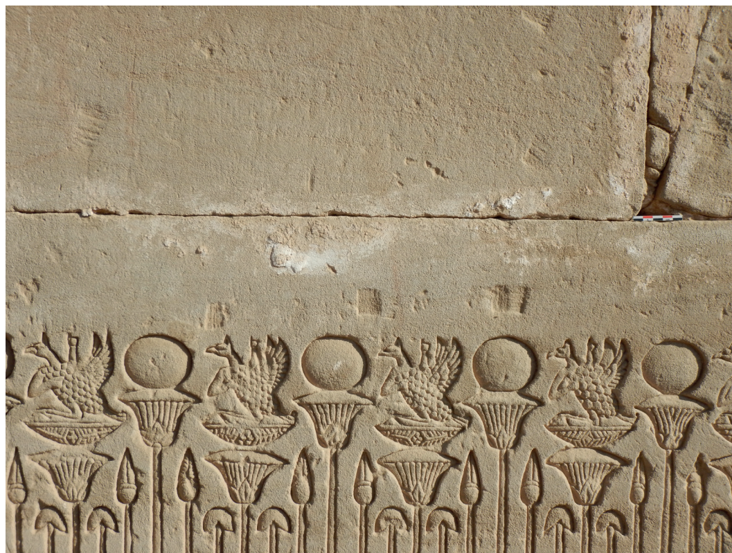
Fig. 2. Dendara, mammisi « romain », extérieur ouest, détail de repères de ravalement au-dessus de la frise basse (second entrecolonnement en partant du sud).
