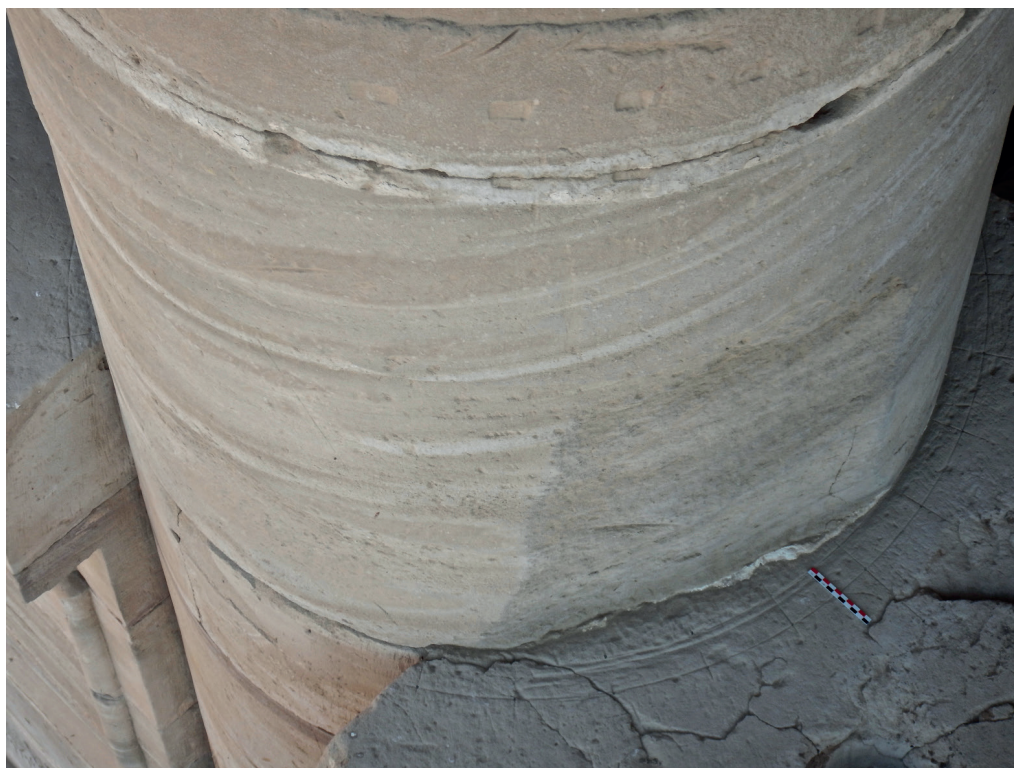
Fig. 20. Dendara, mammisi « romain », portique occidental, colonne au nord de l'axe transversal, détails des repères de ravalement au niveau des liens horizontaux dans la partie supérieure entre le mur d'entrecolonnement et le chapiteau.
