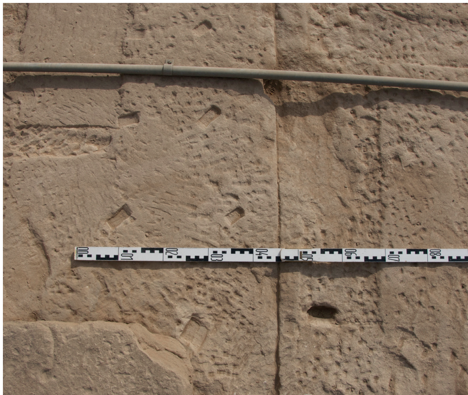
Fig. 29. Dendara, mammisi « romain », toit-terrasse, dalle structurelle présentant des repères de « ravèlement » sur le lit d'attente pour le dallage de revêtement.
