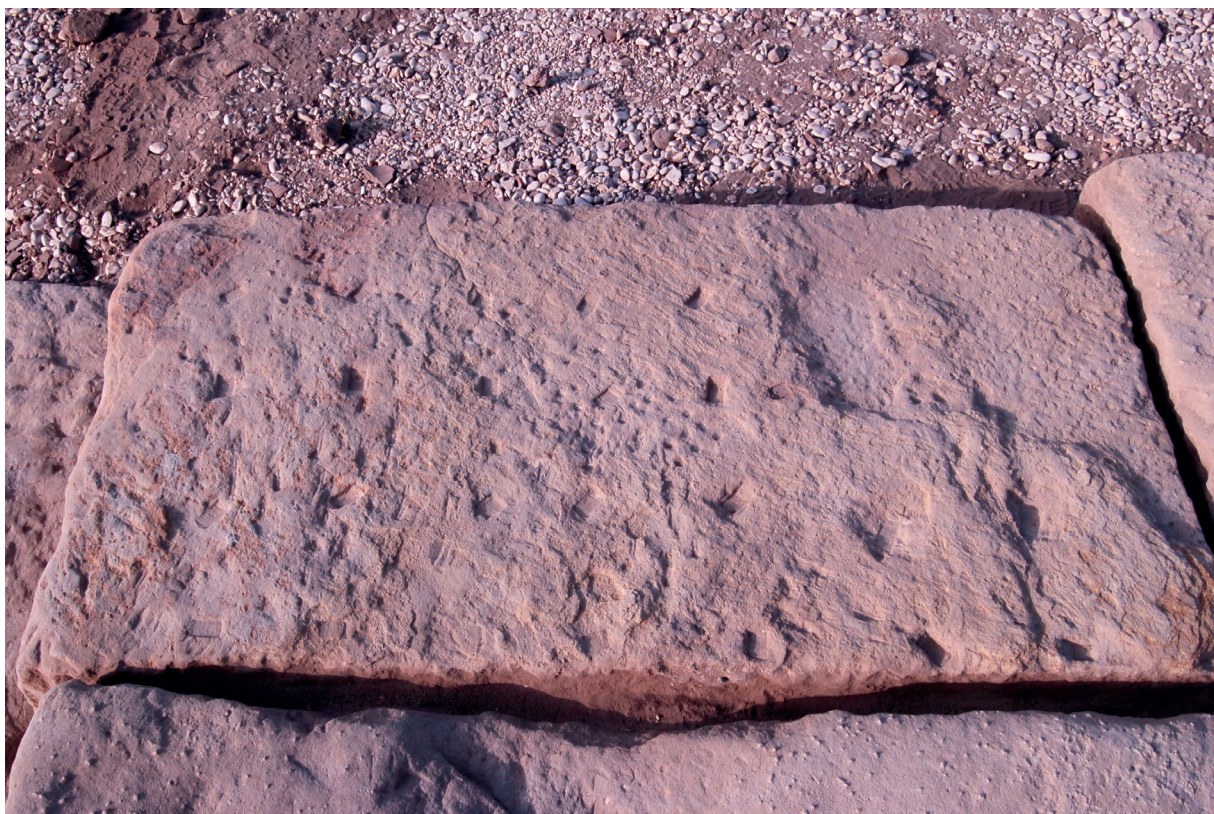
Fig. 33. Dendara, temple d'Hathor, côté nord de la cour, détail d'un bloc disposé dans la fosse de fondation avec des repères de ravalement.
