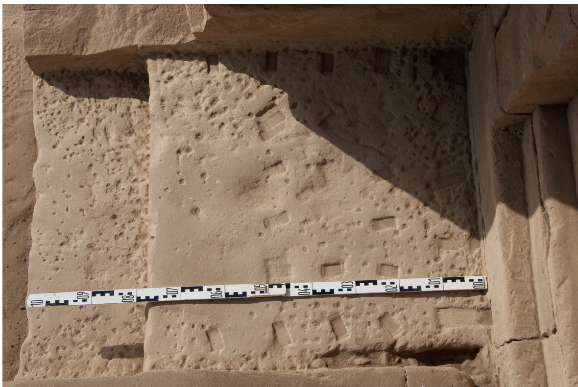
Fig. 23. Dendara, mammisi « romain », palier supérieur de l'escalier, détail de la grille de repères de « ravèlement ».
