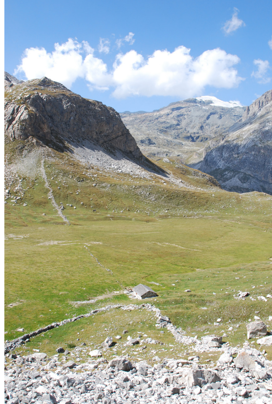
Fig. 18. Exemple de structure pastorale : enclos triangulaire et dispositif de clôture d'un vallon à Peisey-Nancroix, chalet de la Grassaz (2335 m). Photographie P.-J. Rey.
