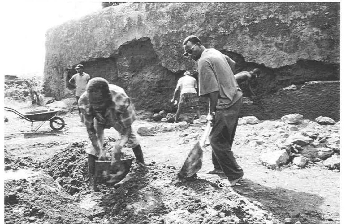
Préparation du mortier de terre stabilisée.
