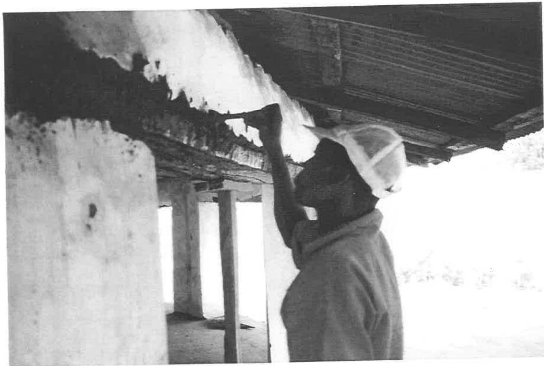
Bouillage de mortier au dessus des nouveaux bois et lissage de l'enduit.
