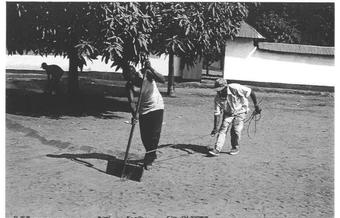
Utilisation du racleur à sable avant de modifier une pente de terrain.
