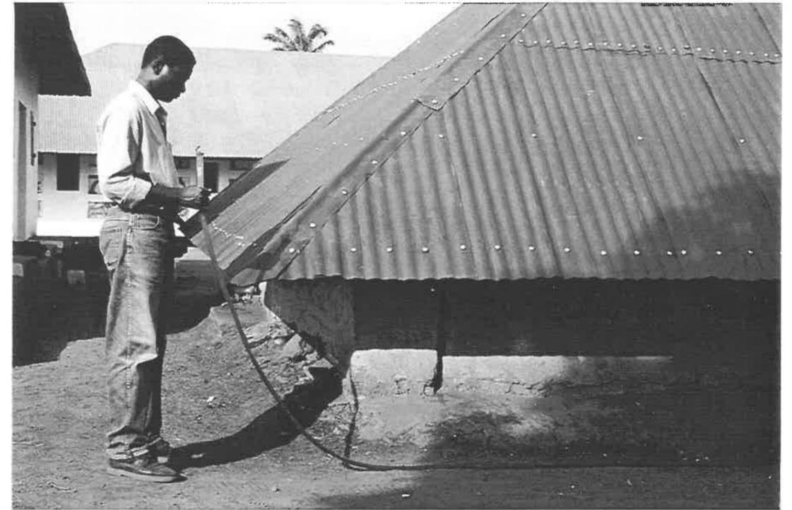
Utilisation du niveau à eau pour vérifier les pentes d'écoulement.
