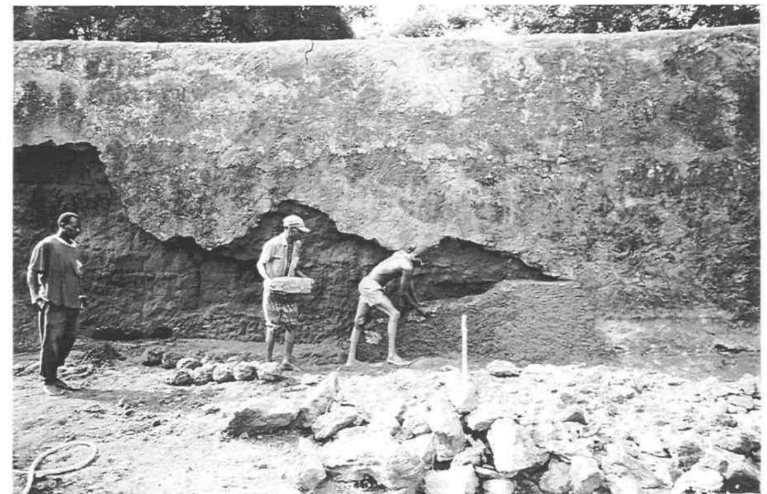
Reconstruction avec les morceaux de l'ancien mur maçonnés à la terre stabilisée.
