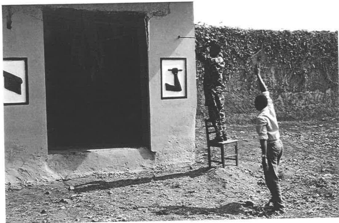
Insertion du tirant métallique par la façade sud, côté place Singbodji.
