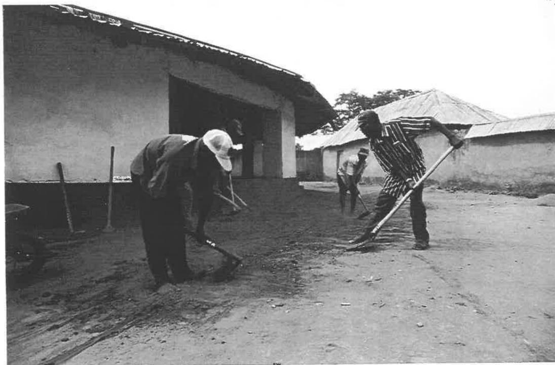
Déplacement du sable de surface et creusement du sol; la terre enlevée est déposée à la base du bâtiment ou elle servira à recréer une pente.
