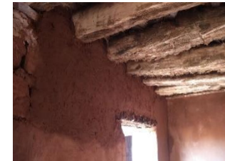
Appliquer en commençant par le haut pour descendre ensuite. Prendre le temps de bien appliquer l'enduit entre les poutres.
