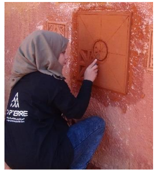
Sculpture de l'enduit au couteau. D'autres outils sont parfois utilisés comme des limes plates ou des morceaux de lame de scie à métaux.
