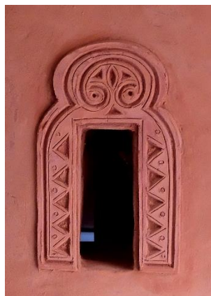
Fenêtre de ventilation sans linteau avec cadre décoré en terre sculptée.
