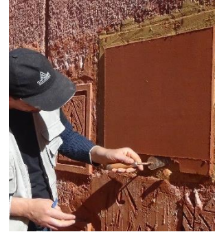
Retrait de l'excès d'enduit autour de la zone de travail.
