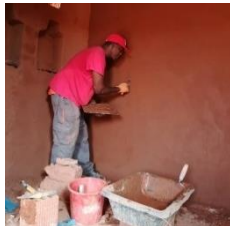
Prendre ensuite le temps de lisser. Installer une planche en pieds de mur pour pouvoir facilement récupérer le mortier qui tombe en cours de pose.
