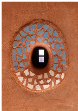
Fenêtre de ventilation sans linteau avec cadre décoré de céramiques récoltées au sol.
