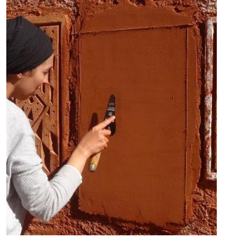
Traçage du contour et dernières retouches de surface.
