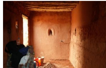
Appliquer en commençant par le haut pour descendre ensuite. Prendre le temps de bien appliquer l'enduit entre les poutres.
