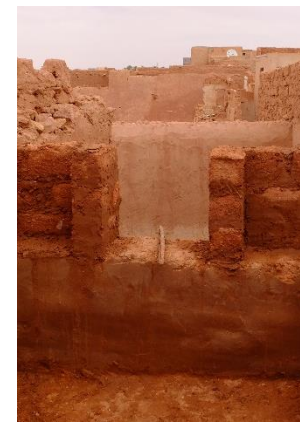
Construction d'une nouvelle ouverture avec jambages en adobes.
