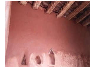
Appliquer en commençant par le haut pour descendre ensuite. Prendre le temps de bien appliquer l'enduit entre les poutres.
