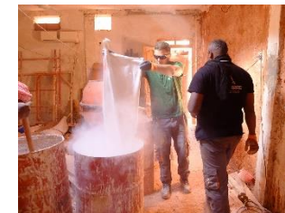
Trempage de la chaux dans des futs avant utilisation.
