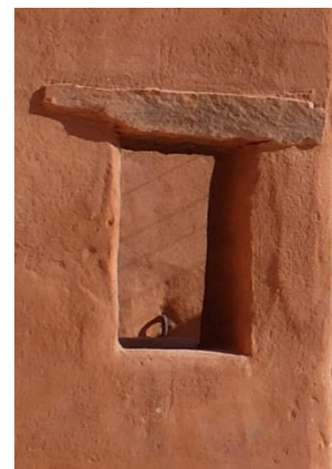
Fenêtre de ventilation avec linteau en pierre.
