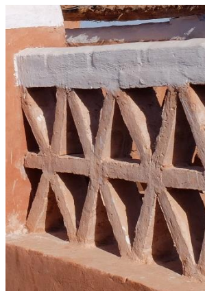
Claustra d'adobes pouvant remplacer une fenêtre de ventilation.
