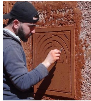
Sculpture de l'enduit au couteau. D'autres outils sont parfois utilisés comme des limes plates ou des morceaux de lame de scie à métaux.
