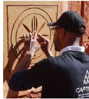
Sculpture de l'enduit au couteau. D'autres outils sont parfois utilisés comme des limes plates ou des morceaux de lame de scie à métaux.
