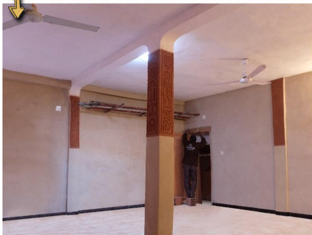
Habillage des poteaux avec des enduits décoratifs en terre et peinture des murs au lait de chaux.
