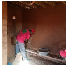
Prendre ensuite le temps de lisser. Installer une planche en pieds de mur pour pouvoir facilement récupérer le mortier qui tombe en cours de pose.
