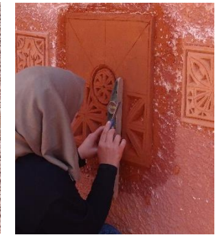
Sculpture de l'enduit au couteau. D'autres outils sont parfois utilisés comme des limes plates ou des morceaux de lame de scie à métaux.
