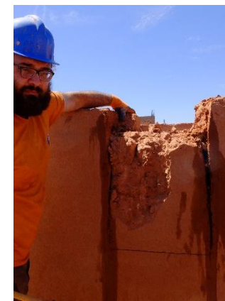
Découpe d'une ouverture avec une scie et de l'eau.
