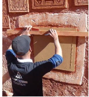
Tracé des grandes lignes du dessin à la règle et au niveau.
