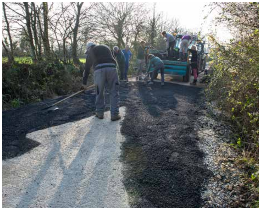
Chantier des quatre saisons – entretien collectif des routes, mars 2017, ZAD NDDL.
