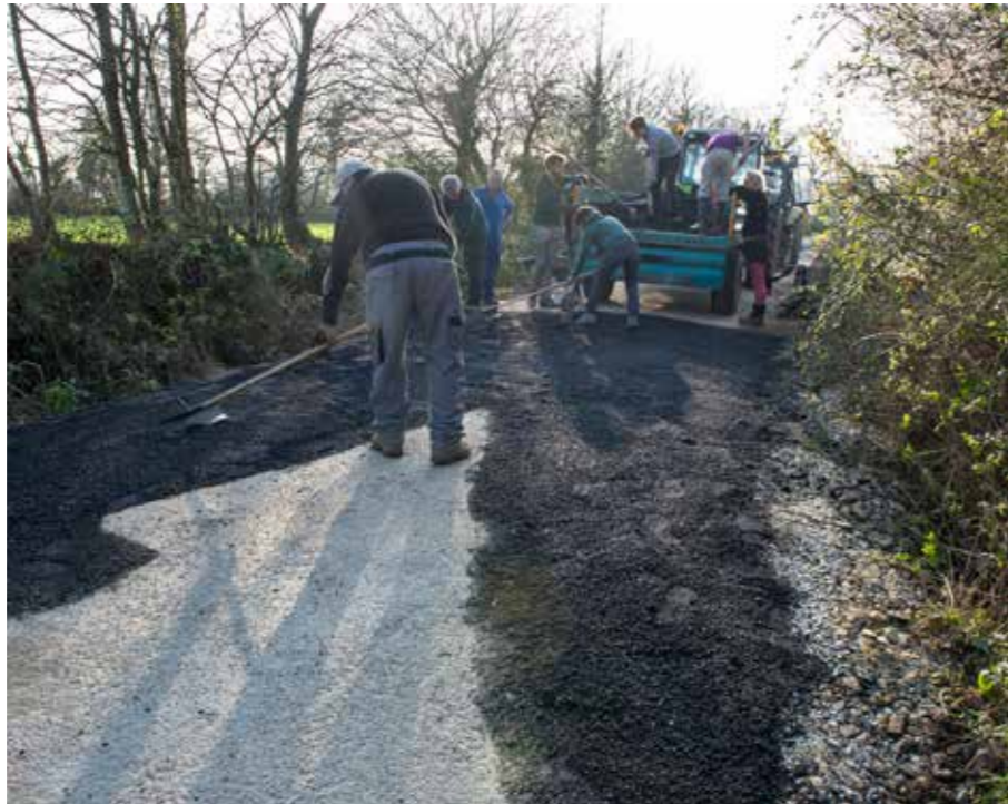
Chantier des quatre saisons – entretien collectif des routes, mars 2017, ZAD NDDL.
