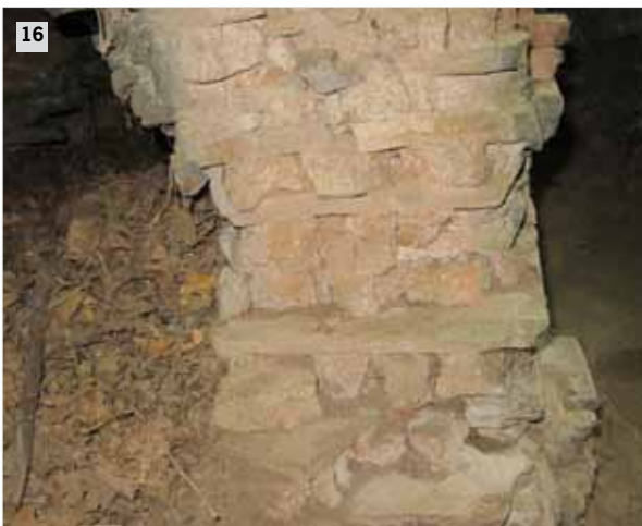
Figure 19 Vue du pilier de la chambre de chauffe. (© Équipe Inrap, 2015)
