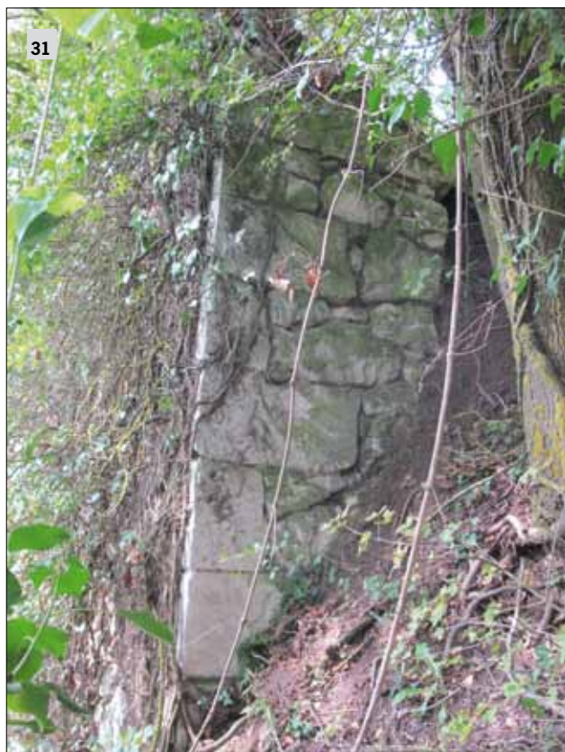
Figure 31 Le chaînage à l'angle oriental du mur UE 36.
