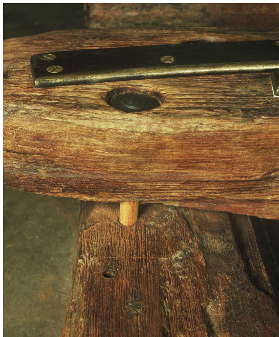
Figure 38 – Même assemblage que la figure 37 vu de l'arrière vers l'avant du châssis laissant apercevoir un des tenons en hêtre. Crédit photographique Paul Mardikian.
