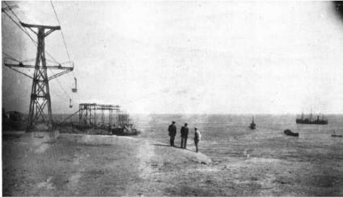
**FIGURA 35:** Torres y carros del funicular de Michilla, el cual trasladaba la producción hacia la fundición ubicada en Gatico. Fuente: Sociedad Nacional de Minería de Chile . Estadística Minera de Chile: 1908-1909 Tomo IV (1910)
