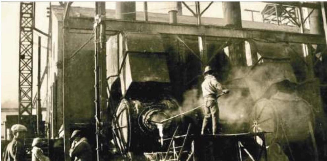
**FIGURA 109:** El metal era vertido en el horno, los obreros provistos de una larga barra de hierro, procedían a perforar el orificio que debía dar la salida del metal fundido formándose un chorro rojo de dos pulgadas dirigido hacia una canaleta de arcilla por donde corría hasta caer a una explanada siendo consecutivamente dirigido hacia una taza de hierro colocada sobre un carro situado en una corta vía del sistema francés Decauville. Archivo D. Galaz-Mandakovic.
