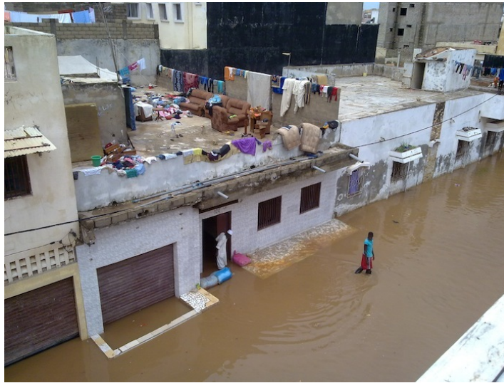
Photo 1: Inondation à la cité Berlvédère à Dalifort
