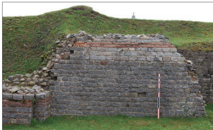
Fig. 7 – Le mur externe MCI19, partie inférieure conservée du premier forum et partie supérieure et soupirail du second (fait architectural 14 ; techniques A-J) dans la branche occidentale du cryptoportique, côté est (cliché : C. Louvion).
