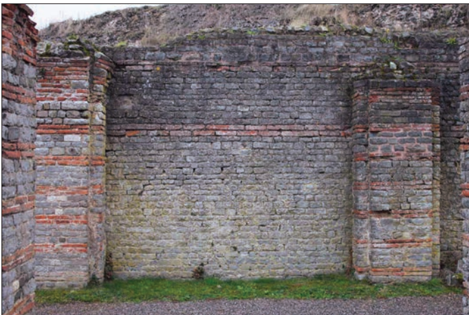
Fig. 4 – Le mur externe ouest MCE27, partie inférieure conservée du premier forum, partie supérieure du second (fait architectural 19 ; technique D) et les demi-piliers PSE27 et PSE28 (fait architectural 20 ; technique A) de la branche occidentale du cryptoportique (cliché : C. Louvion).
