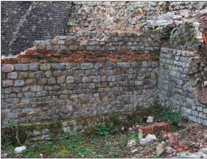
Fig. 3 – Le mur RB27 (fait architectural 6 ; technique H), de la boutique extérieure à l'aire sacrée B027 (cliché : C. Louvion).
