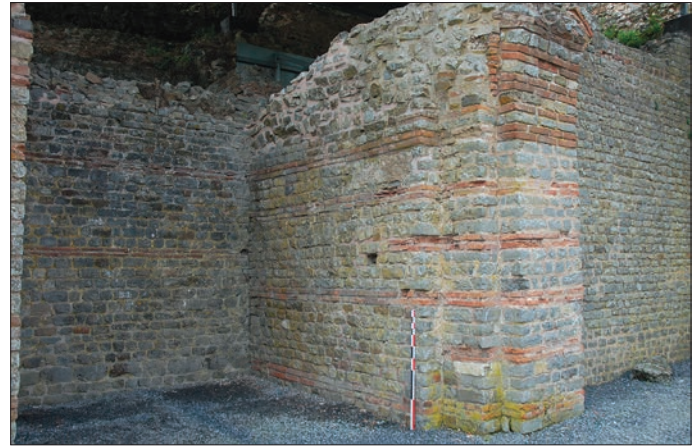
Fig. 6 – Le mur de fond et le mur de latéral EXS4-S/O (fait architectural 16 ; technique C) et le demi-pilier PSE14 (fait architectural 20 ; technique A) de l'exèdre EXN3 de la branche septentrionale du cryptoportique (cliché : C. Louvion).
