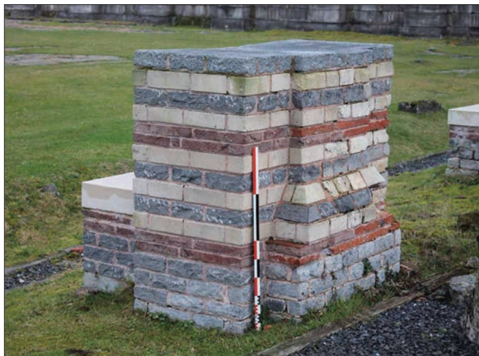
Fig. 14 – Face interne du pilier PTS06 reconstruit à l'identique (fait architectural 31 ; technique B) dans le portique sud de l'esplanade (cliché : C. Louvion).
