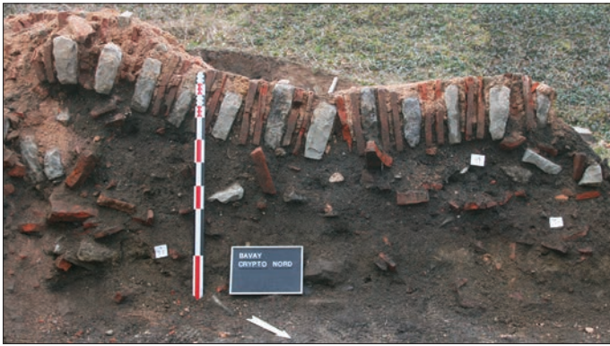
Fig. 9 – Arc effondré ARCT35 (fait architectural 21 ; technique AA) reliant les piliers dans la branche septentrionale du cryptoportique (cliché : C. Louvion).
