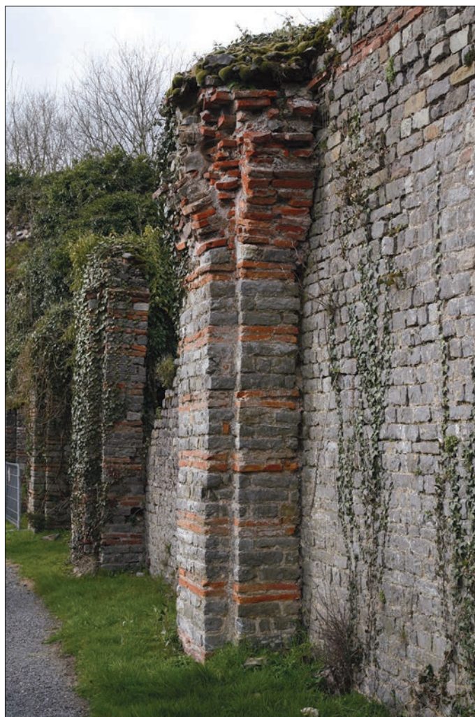
Fig. 8 – Le mur externe MCE32 conservé du premier forum, les demi-piliers PSE31-32 (fait architectural 20 ; technique A) surmontés de leur tas de charge (fait architectural 23 ; technique T) dans la branche septentrionale du cryptoportique (cliché : C. Louvion).
