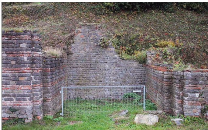
Fig. 5 – Le mur de fond conservé du premier forum et les murs latéraux EXN3-O/E (fait architectural 17 ; technique A) de l'exèdre EXN3 de la branche septentrionale du cryptoportique (cliché : C. Louvion).
