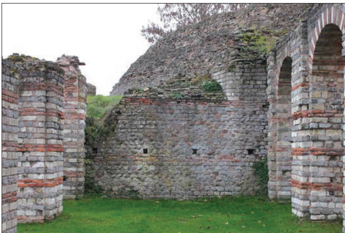
Fig. 11 – Le mur sud MEO14 (fait architectural 25 ; technique I) et les piliers P48-49 et PS07-08 (fait architectural 26 ; technique B) sous l'édifice occidental (cliché : C. Louvion).
