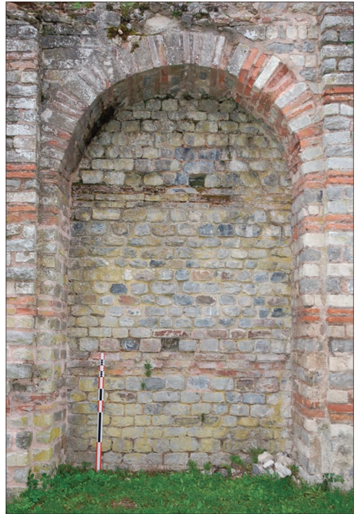
Fig. 12 – Le mur sud MEO04 (fait architectural 25 ; technique I), les demi-piliers PS15-16 (fait architectural 26 ; technique B) et l'arc F01 (fait architectural 27 ; technique AA) sous l'édifice occidental (cliché : C. Louvion).
