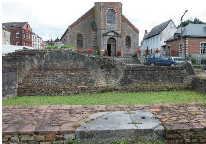
Fig. 17 – Mur MBG11-12 (fait architectural 64 ; technique C) de l'espace basilical ; les arcs de décharge sont en calcaire blanc (cliché : C. Louvion).
