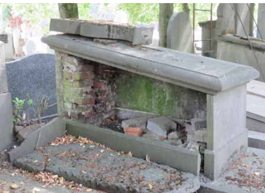
Monument funéraire en forme de coffre, cimetière de Roubaix (Nord). Son état révèle le caractère sommaire de la mise en œuvre.
