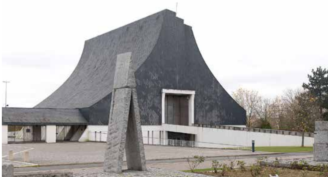
Funérarium du cimetière intercommunal de Valenton (Val-de-Marne).
