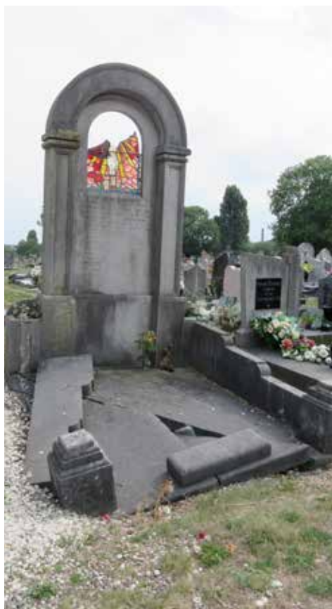
Éclatement de la pierre dû au gonflement des armatures internes en fer. Chapelle des familles Moraud, Brunet et Seailles. Cimetière de Montmartre, Paris.
