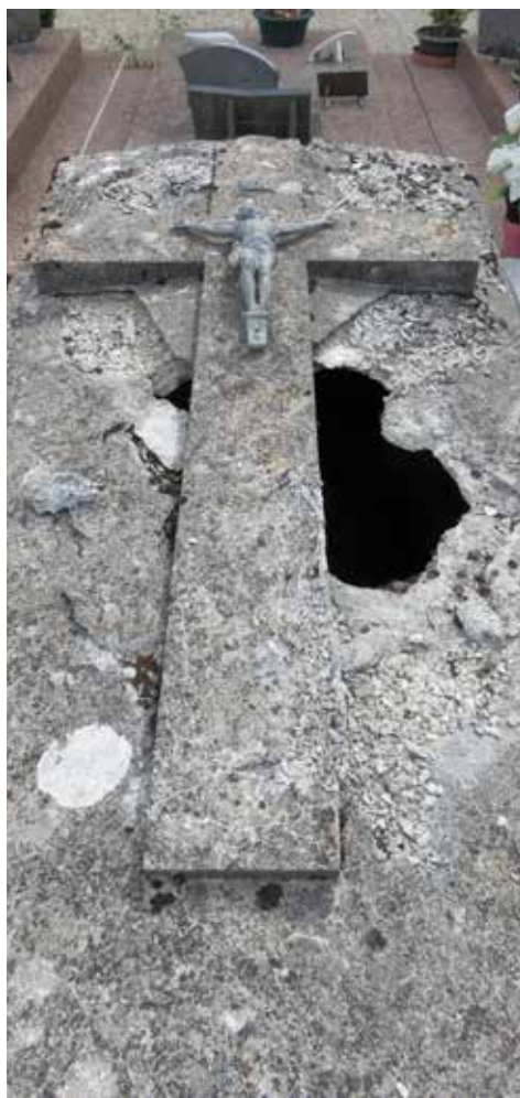
Tombeau en pierre reconstituée, cimetière de la ville basse, Provins (Seine-et-Marne). Une fabrication sans doute défectueuse en a accéléré le délitement.
