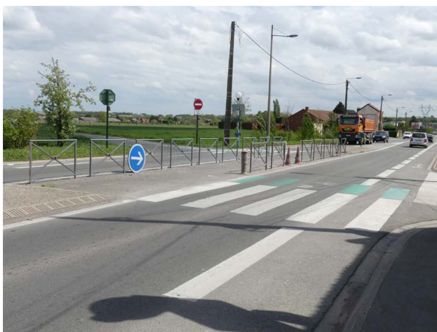
Figure 41 : Aménagement cyclable pour la traversée de la D943
