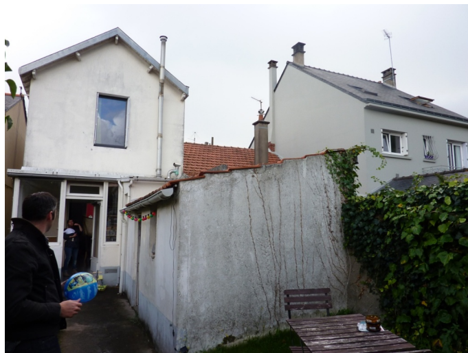
Figure 6. Projet d'extension par MACOBOIS, état existant (façade arrière, véranda et volume perpendiculaire à modifier)
