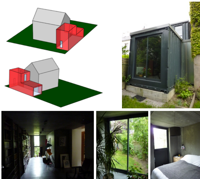
Figure 7. Extension préfabriquée en limite parcellaire ; en haut : volumétrie de la maison avec l'extension en rouge, vue de la façade sud-est ; en bas : vues intérieures du salon en rez-de-chaussée et de la chambre à l'étage
