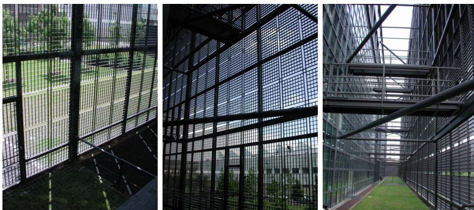
Figure 40. Grille pare-soleil sur la façade Sud
