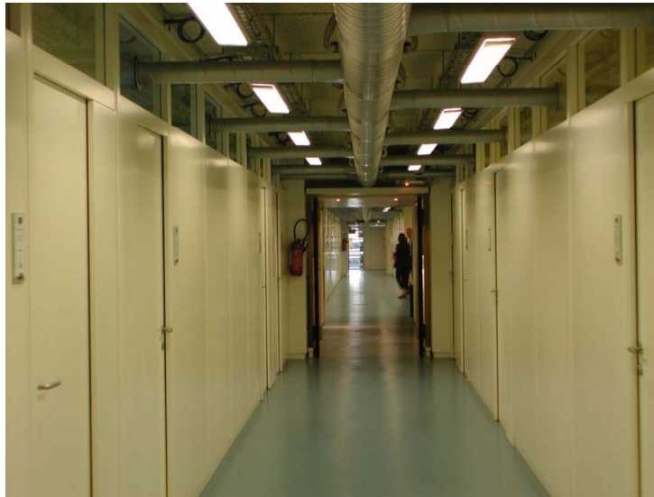
Figure 68. Un couloir de Bordeaux
