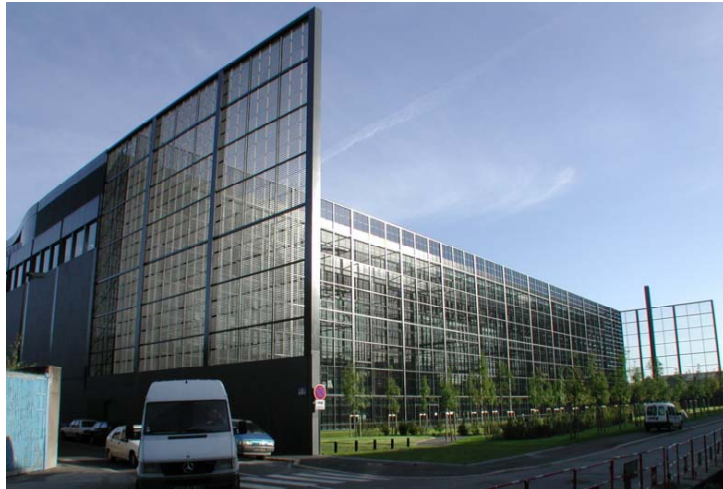
Figure 33. Grilles pare-soleil sur la façade Sud et sur les côtés du jardin
