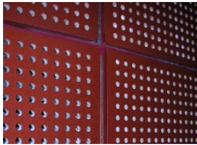
Figure 35. Panneaux perforés des salles d'audience
