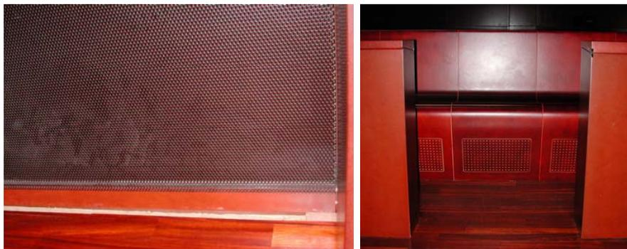
*Figure 38. Soufflage de l'air sous les sièges des salles d'audience*
