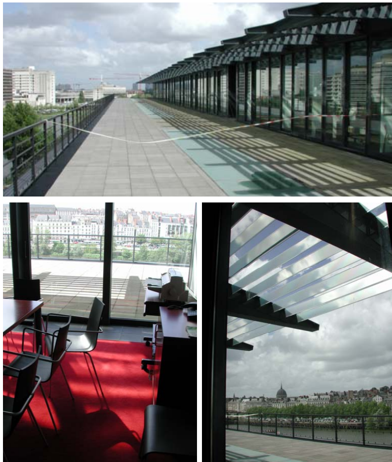
Figure 44. Terrasse Nord (en haut) et système de lamelles de 'rabattage' solaire dans les bureaux (en bas)
