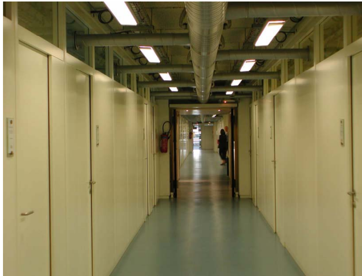
Figure 68. Un couloir de Bordeaux
