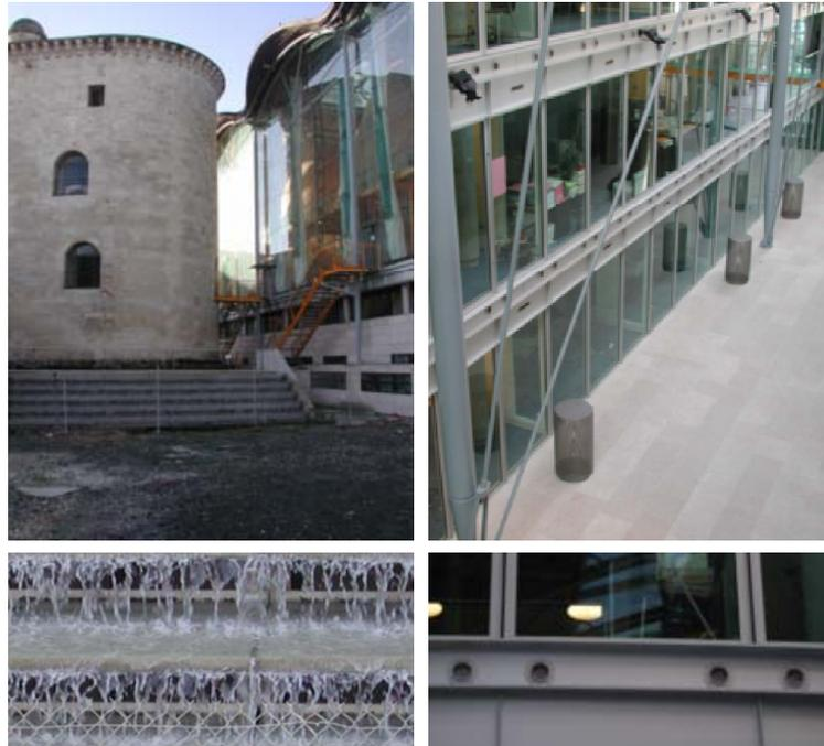
*Figure 45. Cheminement de l'air depuis l'escalier d'eau (à gauche) jusqu'aux bureaux via les corbeilles de l'atrium (à droite en haut) et les prises d'air dans l'épaisseur des dalles (à droite en bas)*
