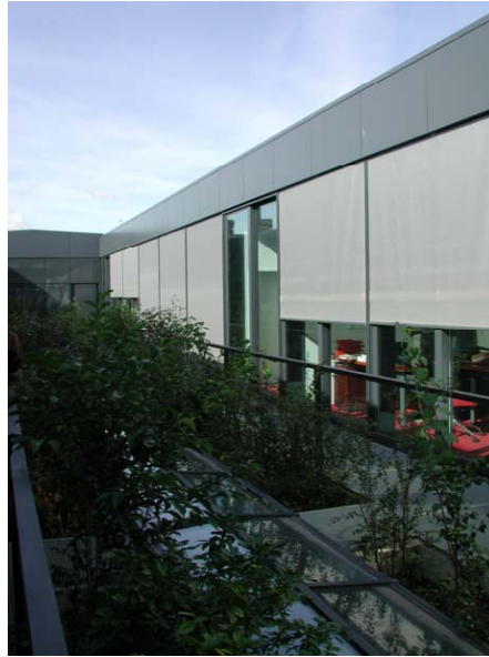
Figure 61. Un patio à Nantes
