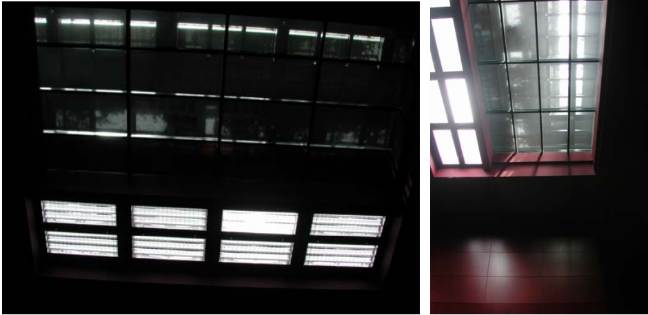
Figure 36. Prise de jour zénithale et caisson lumineux dans une salle d'audience
