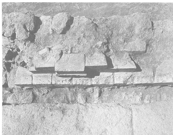
Fig. 5 — Pilastre et base de la façade nord du bustum , vus d'en haut et de face.
