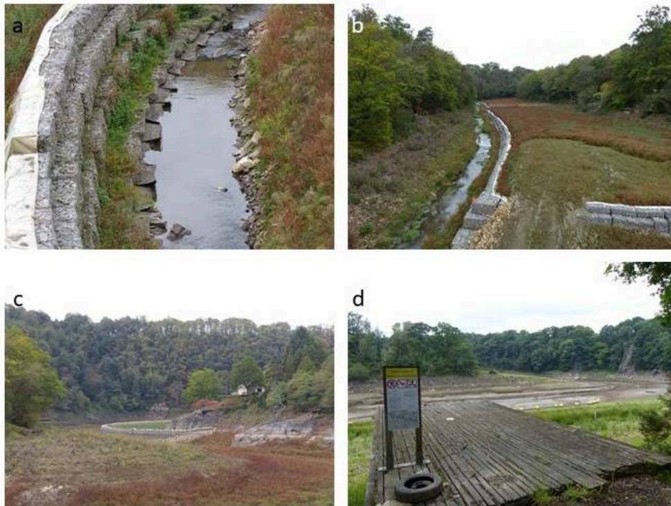
a : Les gabions créés pour déplacer le cours de l'Yvrande, affluent de la Sélune contaminé par des métaux lourds ; b : casiers de stockage des sédiments pollués le long de l'Yvrande, dont le lit a été déplacé en rive droite au pied du versant ; c : stockage de sédiments dans un des méandres du lac ; d : ponton de pêche devant le lac à se).
