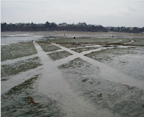
Traces générées par les passages de tractopelles installant les mouillages en baie du Prieuré à Dinard)
