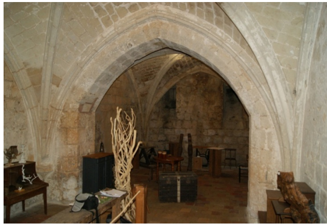
Figure 19 : Vue du niveau 1 du bâtiment 2, murs 102 et 103
