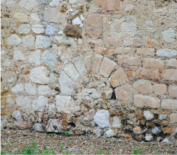
Figure 143 : Baie en plein cintre dans le mur latéral d'une maison rue du château (Troo)
