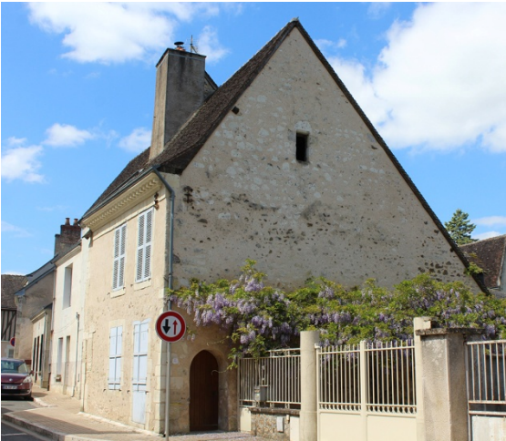
Figure 125 : Maison 12 rue de la Barrière (n°12 Inventaire)
