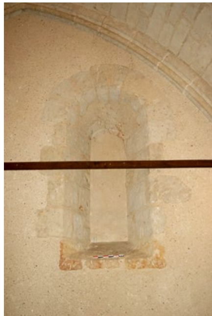
Figure 38 : Face intérieure de la baie 49 (mur 102 bâtiment 2 niveau 2)
