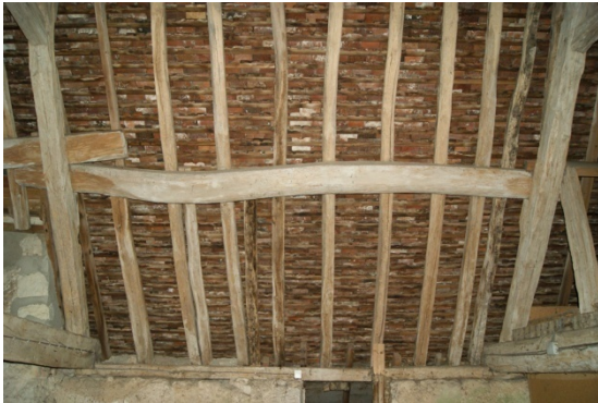
Figure 94 : Vue de la nouvelle panne basse entre les fermes 65 et 66
