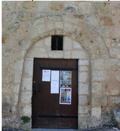
Figure 29 : Face extérieure de la porte 23, transformée lors de la phase 5 (mur 101, bâtiment 2 niveau 1)
