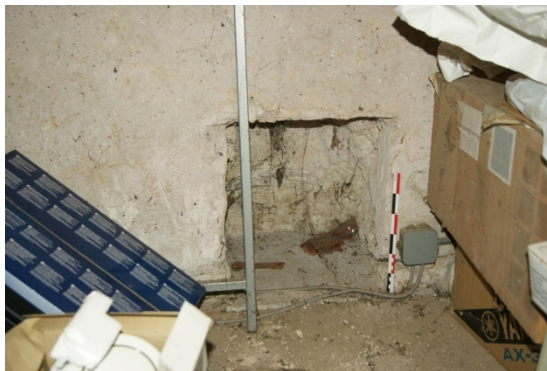
Figure 90 : Un des deux trous d'encastrement dans le mur 102 pouvant correspondre à l'ancrage d'un sommier ou d'un entrant.
