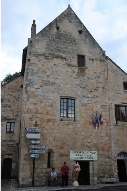
Figure 17 : Façade nord-ouest du bâtiment 2
