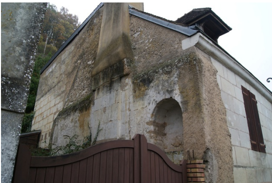
Figure 127 : Maison 37 rue de la Barrière (n°15 Inventaire)
