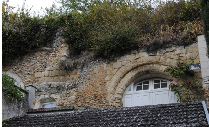
Figure 147 : Ouvertures clavées en plein cintre ouvrant sur des caves, associées à une cheminée à souche cylindrique construite en moellons (chemin des Tombelles, Troo)
