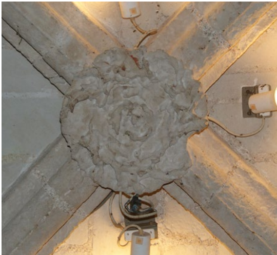
Figure 54 : Détail de la clé de la voûte 42
