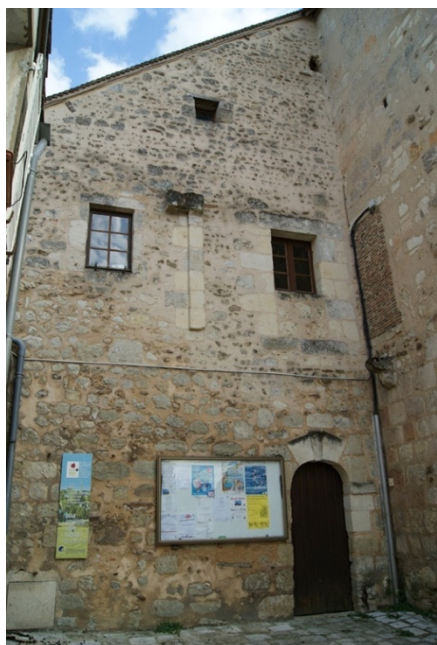
Figure 22 : Façade nord-ouest du bâtiment 3
