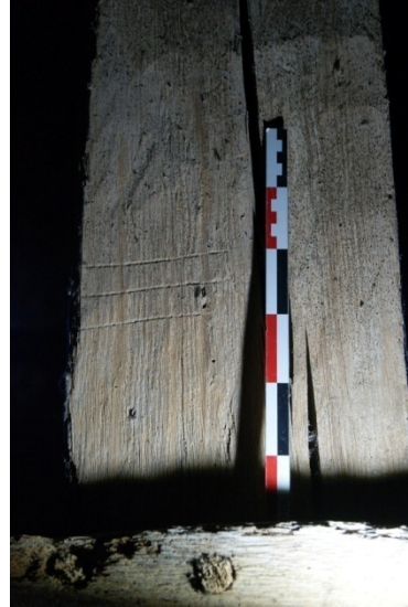
Figure 83 : Chiffre romain employé sur le poinçon pour numérotter la ferme 66
