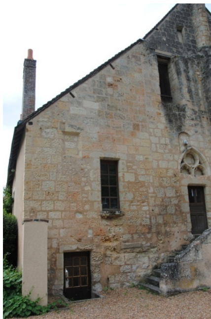
Figure 14: Façade sur cour du bâtiment 1
