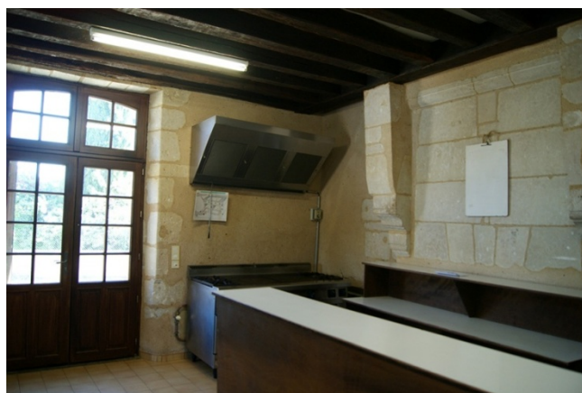
Figure 25 : Vue du niveau 2 du bâtiment 3, murs 103 et 106, porte 77 et cheminée 75
