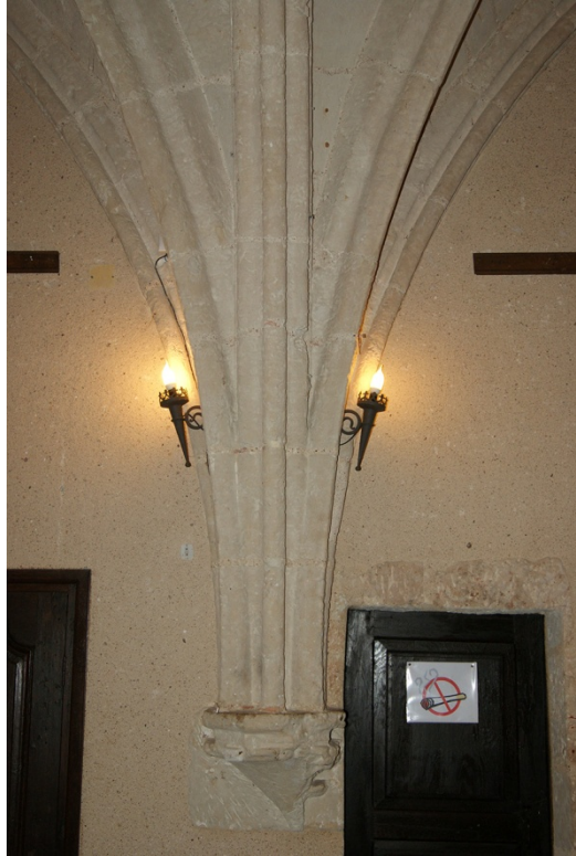
Figure 56 : Détail des ogives et de l'arc doubleau et culot central bûché sur une face pour créer une corbeille lisse
