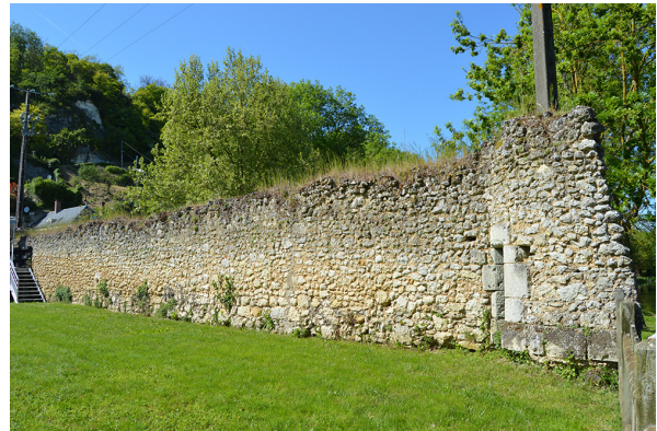
Figure 151 : Enceinte nord et tour près du Loir, face intérieure
