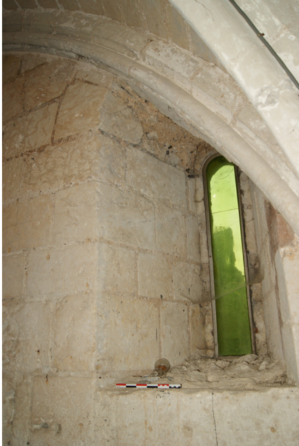
Figure 30 : Face intérieure de la baie 24, perturbée par la voûte 27 (phase 3) (mur 101 bâtiment 2 niveau 1)
