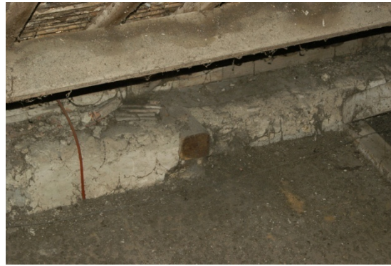
Figure 72 : Bois scié inséré dans le mur 100 pouvant correspondre à une charpente ancienne
