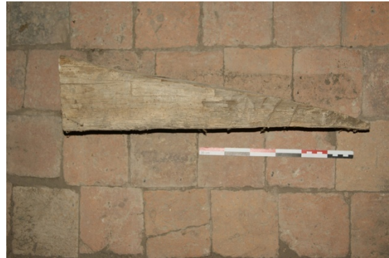
Figure 95 : Vue de profil d'une échantignolle trapézoïdale déposée dans la charpente
