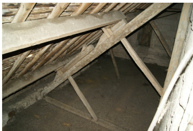
Figure 16 : Vue du niveau 3 du bâtiment 1, charpente et mur pignon nord-ouest (mur 101).
