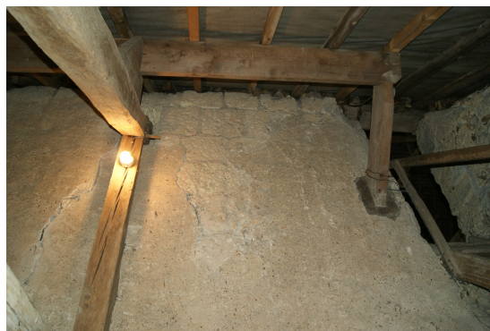
Figure 106 : Détail de la partie haute de la charpente du bâtiment 3, panne et chevrons remplacés et support ajouté lors de la phase 7.
