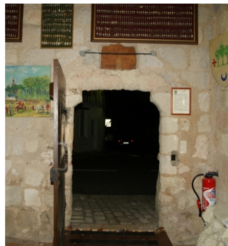
Figure 71 : Face intérieure de la porte 1 (bâtiment 1, niveau 1)
