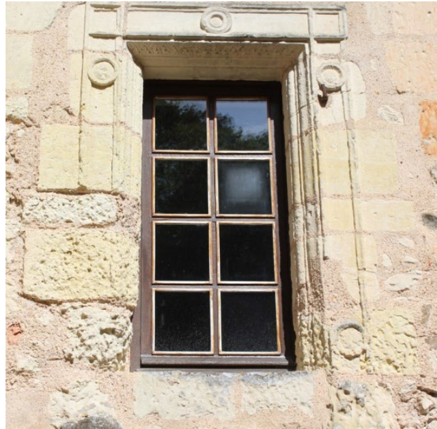
Figure 78 : Fenêtre 37 comportant des décors moulurés de baguettes et médaillons
