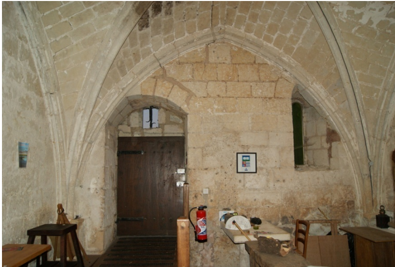
Figure 28 : Face intérieure du mur 101, porte 23 et baie 24 et voûte 27 postérieure (bâtiment 2 niveau 1)
