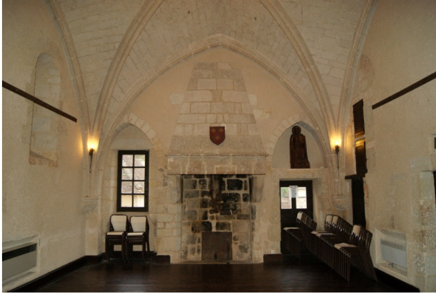
Figure 53 : Voûte 42 de l'étage, extrémité est de la pièce (niveau 2 bâtiment 2)
