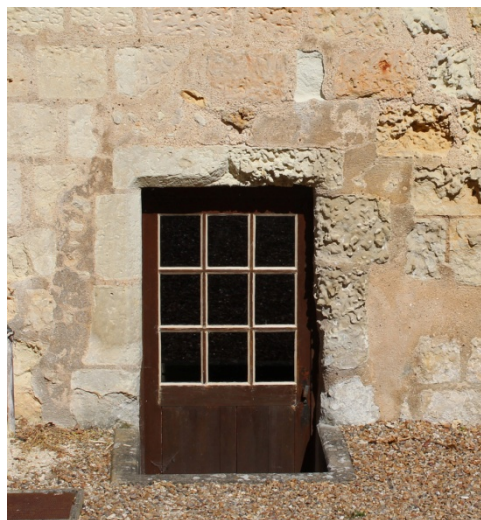
Figure 76 : Porte 7 ouvrant à mi hauteur des niveaux 1 et 2 (bâtiment 1)
