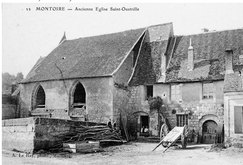
Figure 130 : Église Saint-Oustrille à Montoire, vue du nord (carte postale ancienne)
