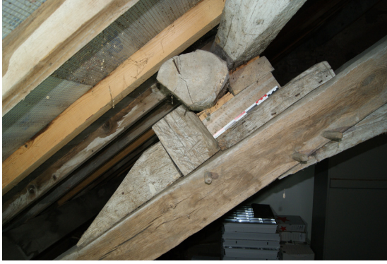
Figure 103 : Échantignolles et pannes anciennes calées sur la ferme 84
