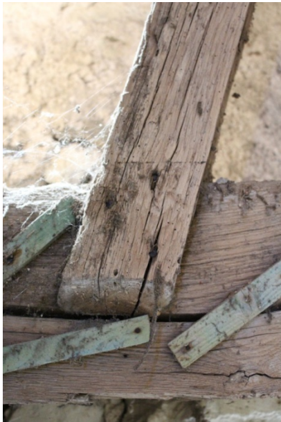
Figure 99 : Détail des lignages au charbon sur la jambe de force ajoutée à la ferme 67
