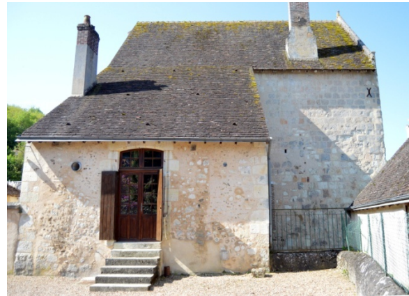
Figure 9 : Façade nord-est sur la cour (bâtiments 2 et 3)
