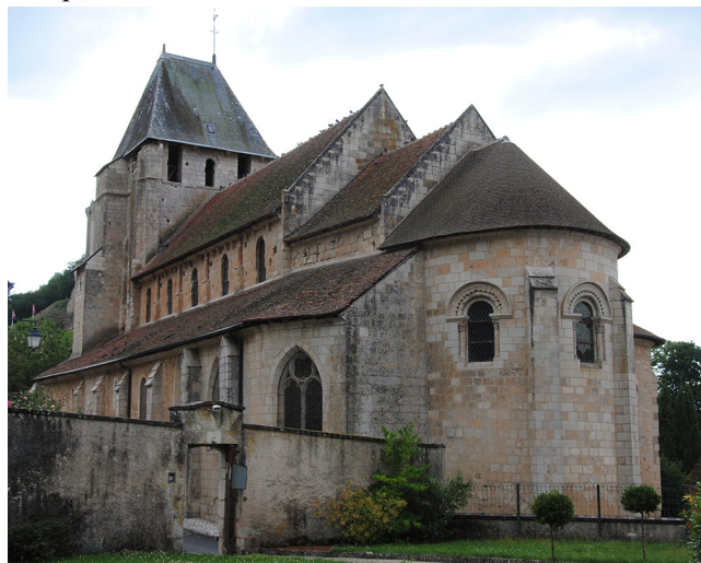
Figure 41 : Vue d'ensemble de l'église Saint-Genest depuis la mairie de Lavardin (du sud-est)
