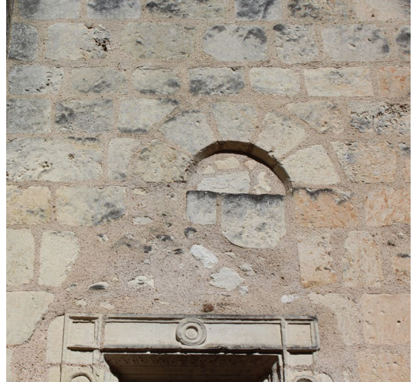
Figure 36 : Face extérieure de la baie en lancette 38 (phase 1), perturbée par la fenêtre 37 à médaillons sculptés phase 4) (mur 103, bâtiment 2 niveau 2)
