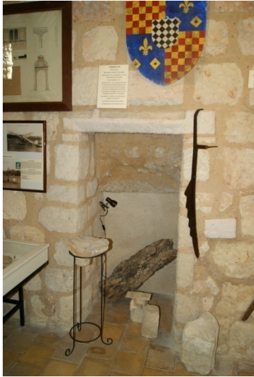
Figure 91 : Porte 3 réutilisant un bloc mouluré comme linteau
