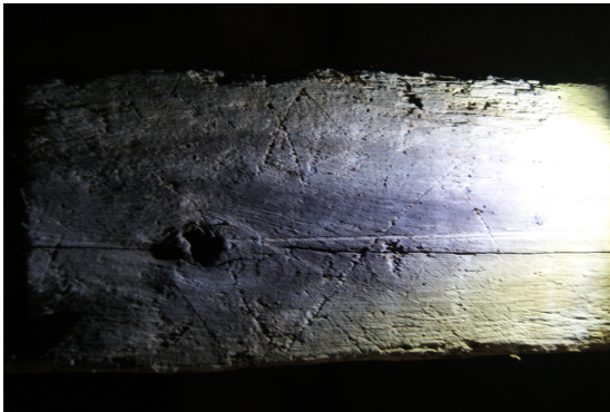
Figure 104 : Numérotation V sur la sous-face du faux-entrait de la ferme 84
