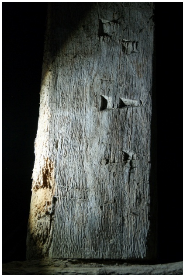
Figure 84 : Marque à encoche sur le poinçon de la ferme 66
