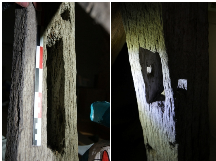
Figure 102 : Vues sur les deux mortaises vides de la jambe de force de la ferme 84
