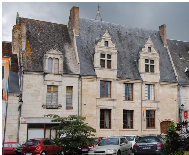
Figure 135 : Maisons du 16 e siècle inscrites aux Monuments Historiques situées place Clémenceau à Montoire
