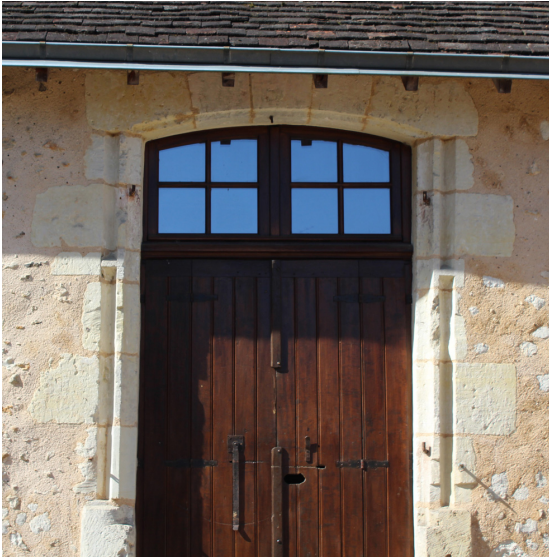
Figure 86 : Porte 77 correspondant à une ancienne baie à croisée (bâtiment 3)
