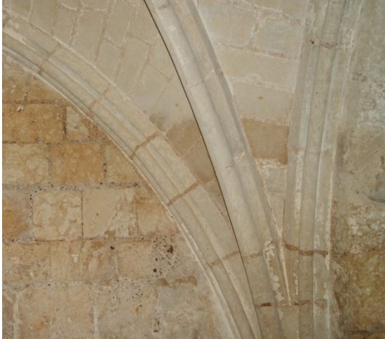
Figure 47 : Détail des arcs formerets et arc d'ogive de la voûte 28
