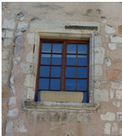
Figure 75 : La fenêtre 18 au linteau mouluré d'un larmier (bâtiment 1 niveau 2)
