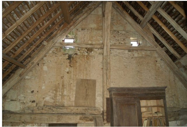
Figure 64 : Ferme 64 plaquée contre le pignon nord-ouest (mur 101) et ouvertures 60 et 61.
