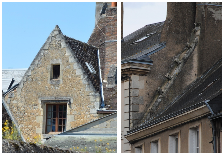
Figure 136 : Exemples de bâtiments à pignons découverts conservés à Montoire
