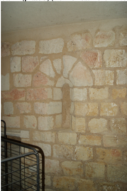
Figure 32 : Face extérieure de la baie 4 (mur 104, bâtiment 2 niveau 1)
