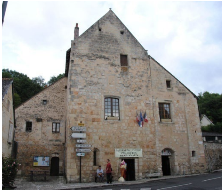
Figure 7 : Façade nord-ouest sur la rue (bâtiments 1 à 3)
