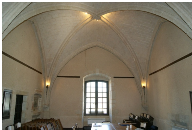
Figure 52 : Voûte 42 de l'étage, extrémité ouest de la pièce (niveau 2 bâtiment 2)
