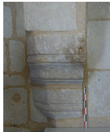
Figure 89 : Détail de la console moulurée de la cheminée 75
