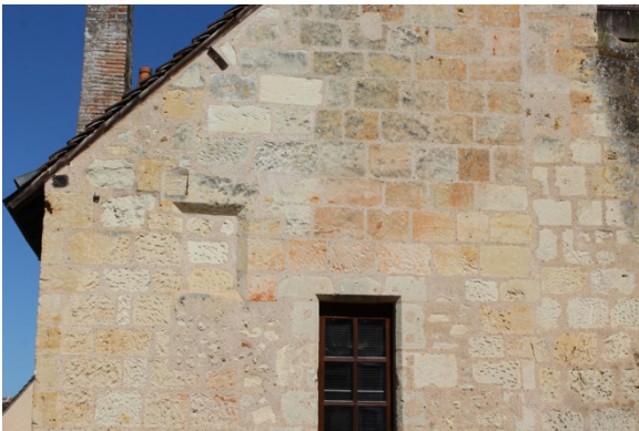
Figure 67 : Pignon sud-est du bâtiment 1, fenêtre 22 chanfreinée bouchée
