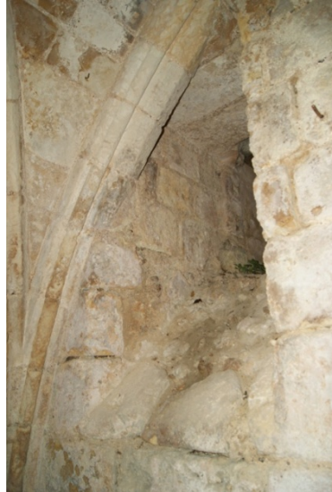
Figure 51 : Ouverture 26 remaniée au moment de la construction de la voûte 28
