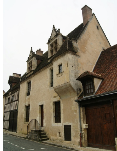
Figure 118 : Maison 22 rue de la Barrière (15 e et 16 e siècles) (n°5 Inventaire)
