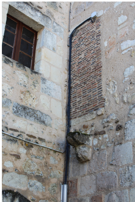
Figure 98 : Bouchage de la porte 46, transformée en placard, et réduction de la porte 79 en fenêtre
