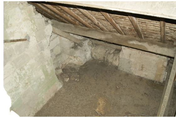
Figure 68 : Face intérieure du pignon sud-est du bâtiment 1 avec l'ouverture 22 couverte d'un arc puis remaniée pour créer l'ouverture 92
