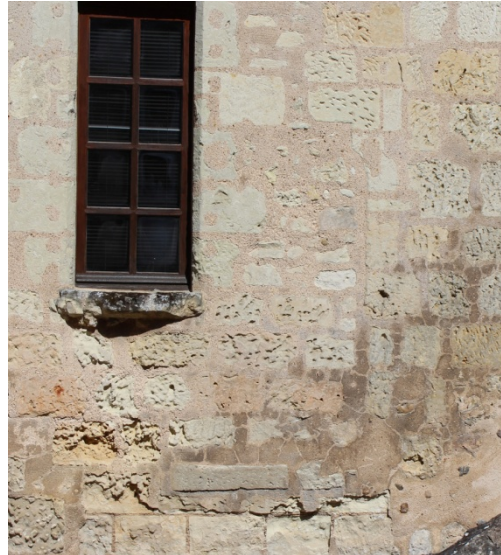
Figure 69 : Porte 21 à linteau sur coussinet, détruite partiellement par la création de la fenêtre 20
