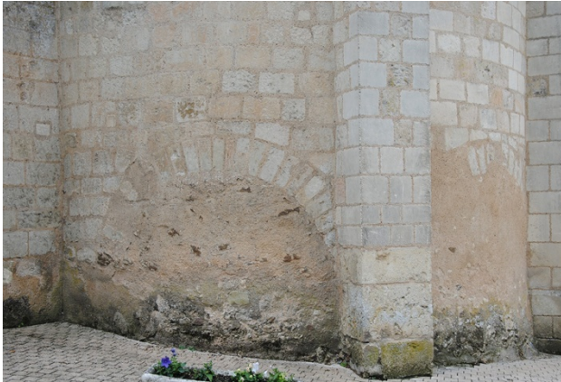
Figure 42: Détail des arcs de décharge de l'abside centrale du chevet de l'église Saint-Genest de Lavardin
