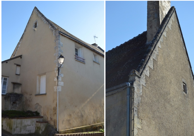
Figure 153 : Maisons à pignon à crossettes rue du Tertre des Boulangers (Thoré-la-Rochette)
