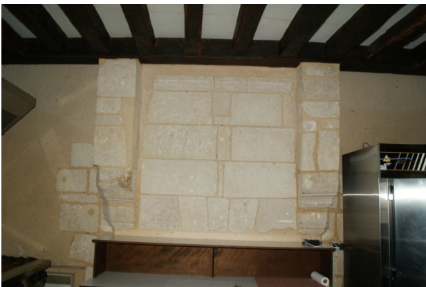
Figure 88 : La cheminée 75 (bâtiment 3 niveau 2)
