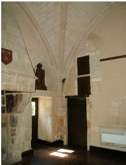
Figure 79 : Placards 58 à l'angle sud du bâtiment 2, niveau 2
