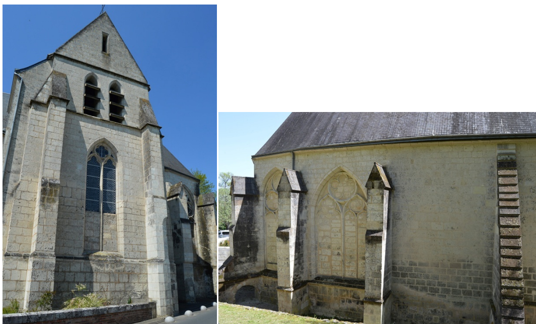
Figure 149 : Église Saint-Almyr des Roches-l'Evêque, façade sur la rue et façade arrière avec contrefort et baies à remplages bouchées
