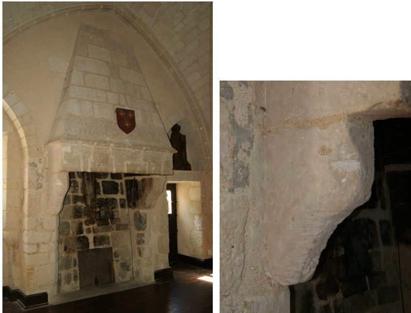
Figure 59 : Cheminée 39 à hotte pyramidale et corbeaux moulurés (phase 3)
