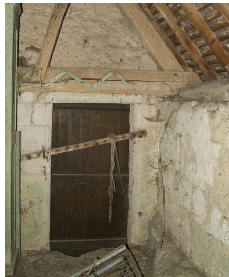
Figure 80 : Porte 70 ouvrant au niveau 3 du bâtiment 2 à l'arrière du bâtiment
