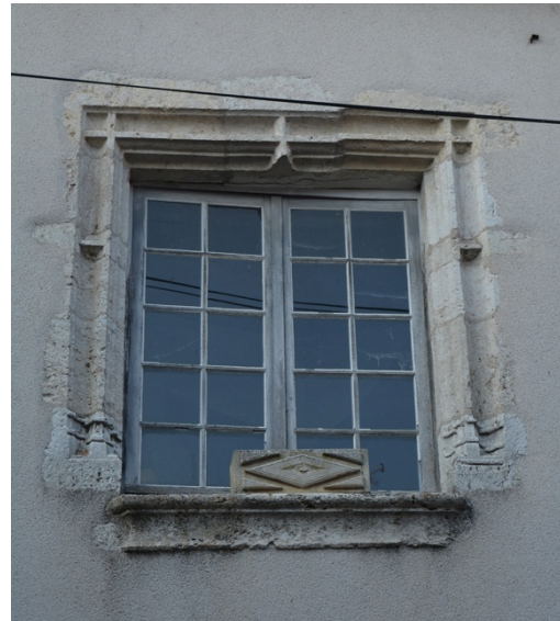
Figure 87 : Fenêtre à croisée du 19 rue Pierre Pouteau à Suèvres (Loir-et-Cher)
