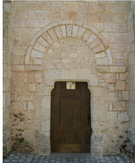
Figure 43 : Porte sud de la nef de l'église Saint-Genest de Lavardin
