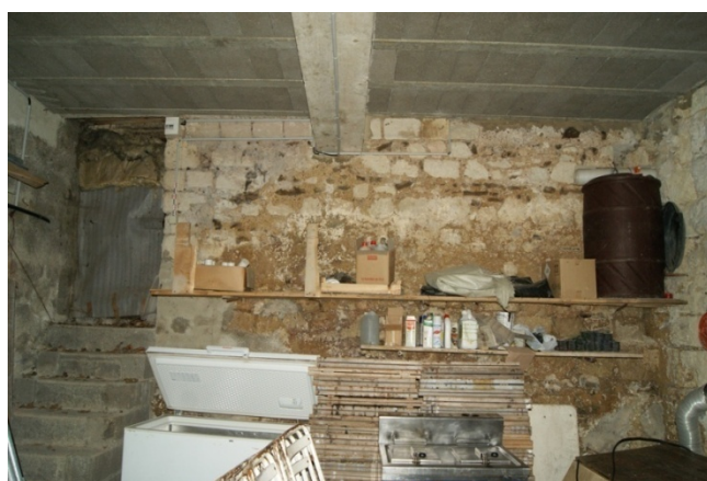
Figure 24 : Vue du niveau 1 du bâtiment 3, mur 103 et porte 74
