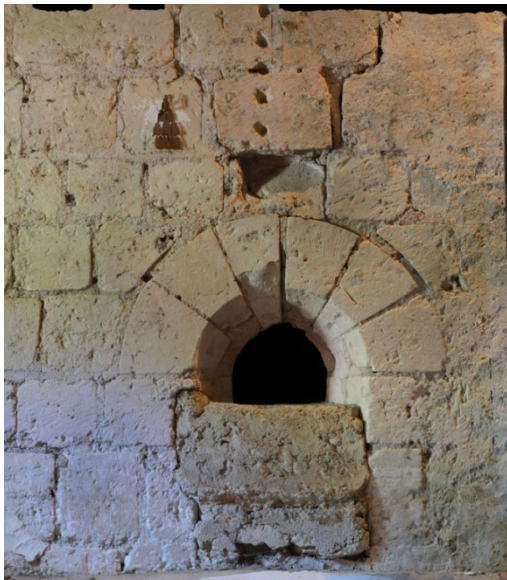
Figure 37 : Face extérieure de la baie 49 (mur 102, visible au niveau 3 du bâtiment 3)
