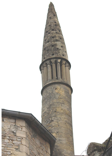
Figure 39 : Souche de cheminée du 1-3 rue des Chanoines à Bayeux, 13 e siècle
