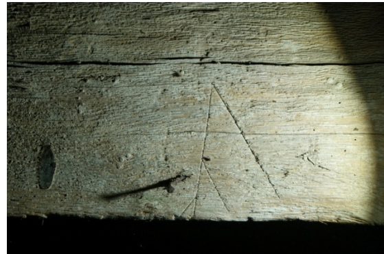
Figure 85 : Marque de charpentier représentant le chiffre 7 sur l'entrait de la ferme 65
