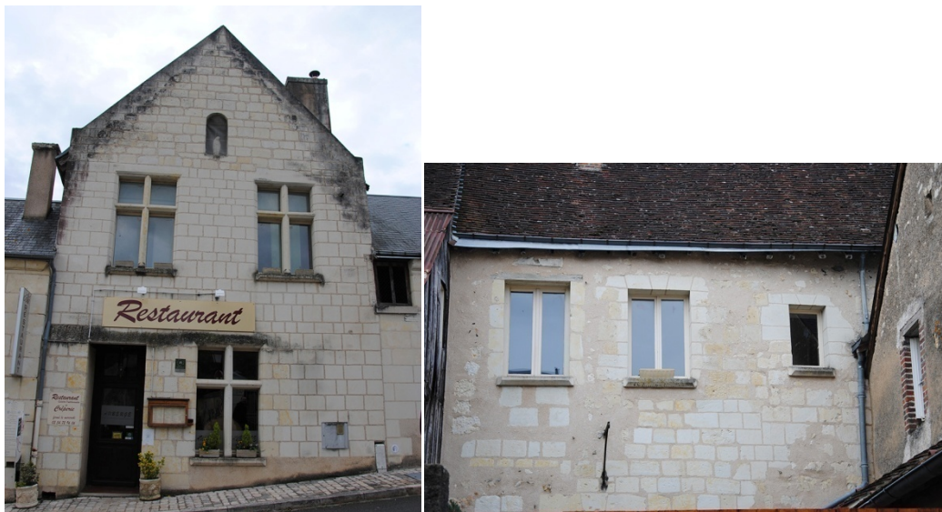
Figure 142 : Auberge Sainte-Catherine, façade sur bâtiment sur rue avec pignon et croisées et mur gouttereau du bâtiment arrière, construit en moyen appareil (Troo)
