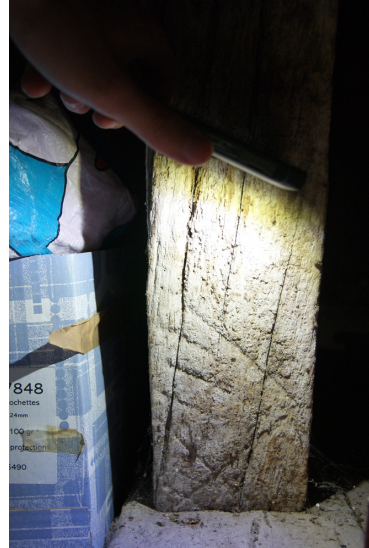
Figure 105 : Numérotation VIII à la base de la jambe de force de la ferme 84
