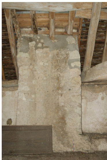
Figure 93 : Conduit de la cheminée 45 visible au niveau 3 et reprise associée du chevronnage de la charpente
