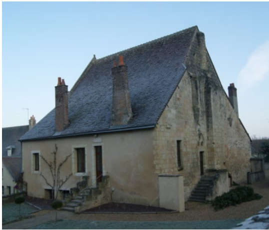
Figure 8 : Façades sud-ouest et sud-est sur la cour (bâtiments 1 et 2)
