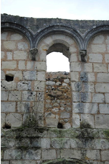
Figure 139 : Détail d'une baie de la maladrerie de Troo
