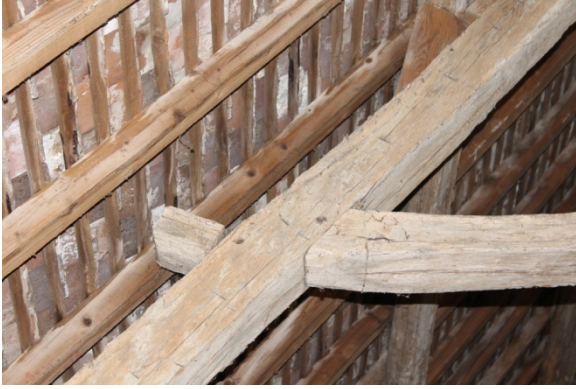
Figure 82 : Exemple d'échantignolle quadrangulaire située à hauteur du faux-entrait d'une ferme
