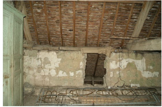
Figure 92 : Ouverture 69 percée dans le mur 104 entre les bâtiments 1 et 2 au niveau du comble (vue du bâtiment 2)
