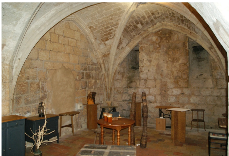
Figure 46 : Vue d'ensemble du niveau 1 du bâtiment 2, ouvertures 25 et 26 dans le mur du fond (phase 1?) et voûtes sur croisées d'ogives de la phase 3 (VOU 27 et 28, ARC 29).
