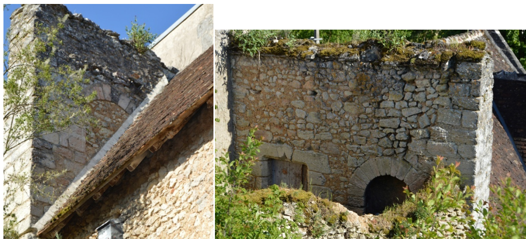
Figure 155 : Maison 2 sentier de l'Église (Thoré-la-Rochette), mur arrière avec ouverture en plein cintre à claveaux étroits
