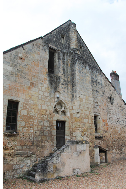
Figure 18 : Façade sud-est du bâtiment 2
