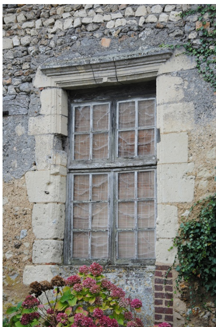
Figure 145 : Fenêtre à croisée moulurée d'une maison située rue du Château (Troo)
