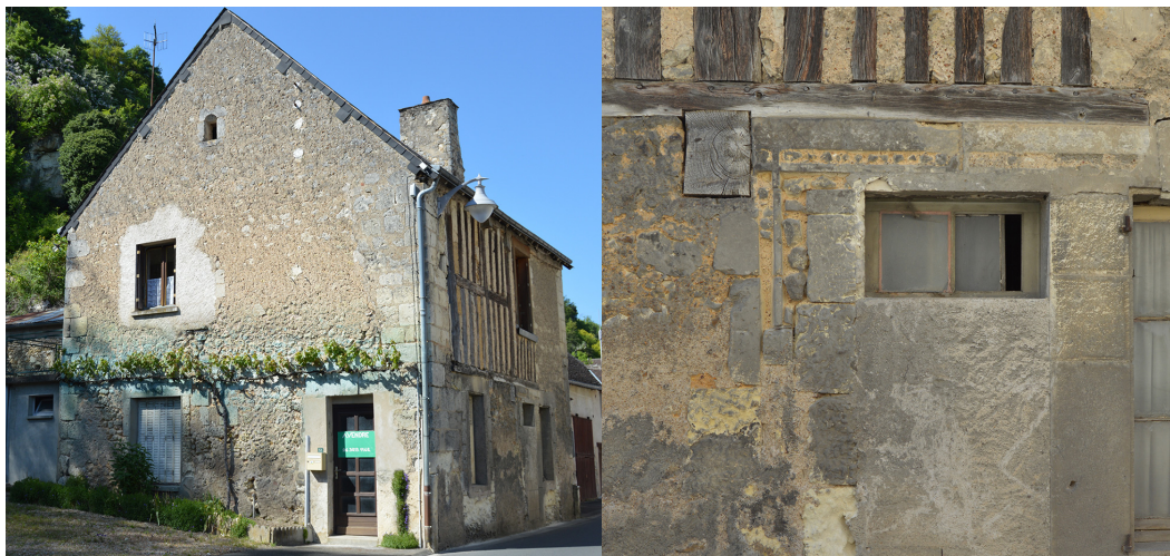
Figure 152 : Maison 53 grande Rue (Les-Roches-l'Evêque) et détail d'une baie moulurée bouchée
