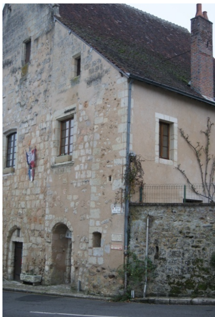
Figure 13 : Façade sur rue du bâtiment 1
