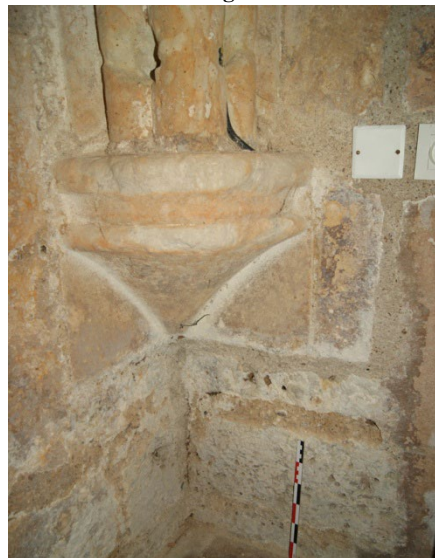
Figure 50 : Détail d'un culot de la voûte 28 à corbeille lisse (bûché)
