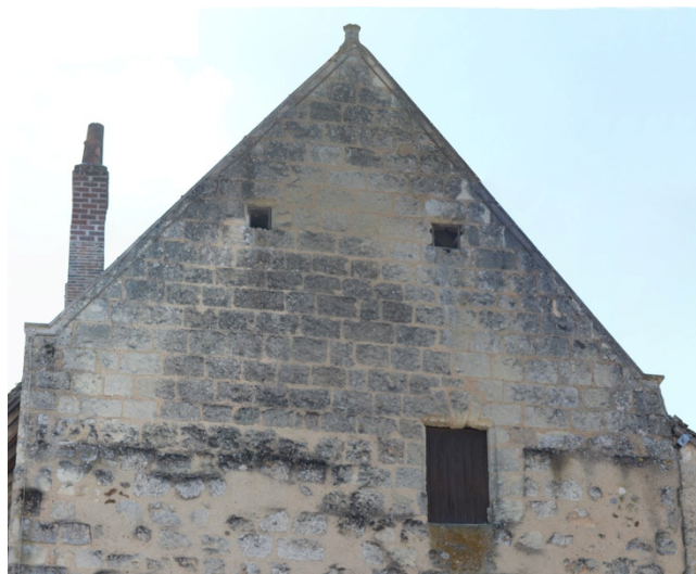
Figure 63 : Sommet du pignon nord-ouest du bâtiment 2 (mur 103, phase 3)
