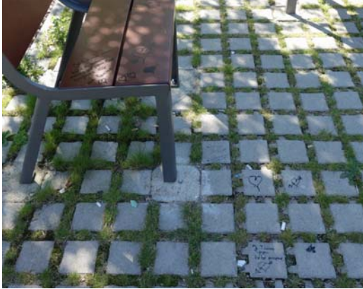
Figure n°7. Pavement en amont de la noue centrale (photographie auteur W Hucy, 2016)
