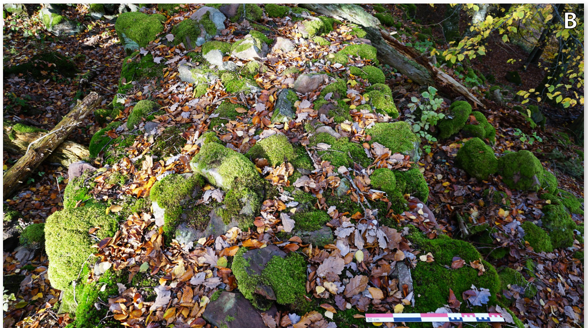
Figure 46 : Vues du rempart du Petit Ringelsberg , vers le nord (A) et détail de sa largeur conservée (B) (Clichés : S. Gentner)
