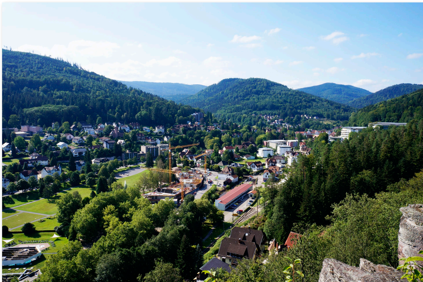
Figure 53 : Vue vers le sud du carrefour de Bad Herrenalb à partir des falaises du Falkenstein . L'éperon à l'arrière-plan, au centre, correspond au Wurstberg (Cliché : S. Gentner)
