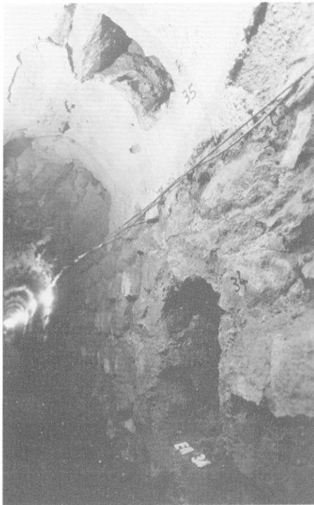
Fig. 49 — Egout de la Voie II : sous la porte charretière des Grands Entrepôts, le débouché n° 34 (état 2B de la Voie II) est remplacé par le débouché n° 35 (restauré).
