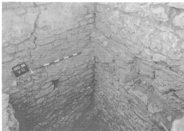
Fig. 62 — Zone V : angle nord-est du portique I (état 2B). Sur la droite, le mur de façade M3 (état 2C) porte les traces d'un crépi blanc qui se retrouve, à gauche, sur le mortier de support de la peinture murale disparue de l'état 2B.
