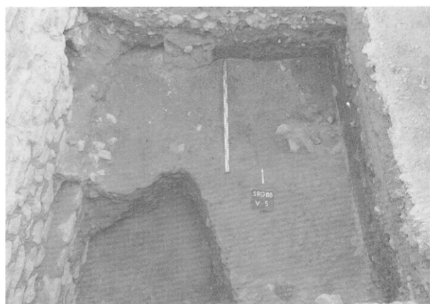
Fig. 53 — Zone V, cellule 2 : sur la gauche, trou dans le mur M406 (état 2C) correspondant à la récupération d'un tuyau en plomb desservant la maison au Vestibule à Colonnes. Au centre et sur la droite, support de pilier (?) et maçonnerie sommaire (cloisonnage ?) (état 2B).
