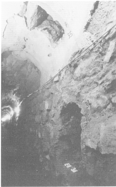
Fig. 49 — Egout de la Voie II : sous la porte charretière des Grands Entrepôts, le débouché n° 34 (état 2B de la Voie II) est remplacé par le débouché n° 35 (restauré).
