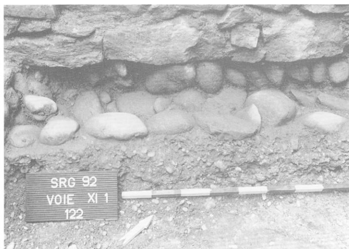
Fig. 9 — A gauche, Voie II 2 : détail des fondations du mur M9 (état 1A). A droite, Voie XI (place Triangulaire) : fondations sur lits de galets.
