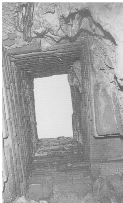
Fig. 34 — Voie II : regard R4 avant restauration.
