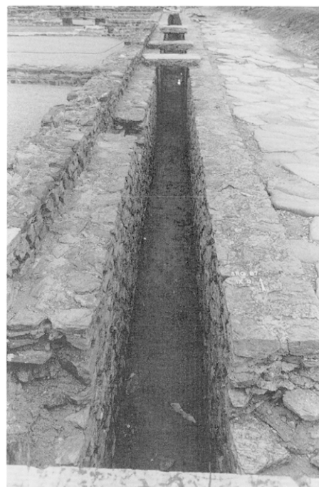
Fig. 36 — Voie II : trottoir sur drain (état 2E).
