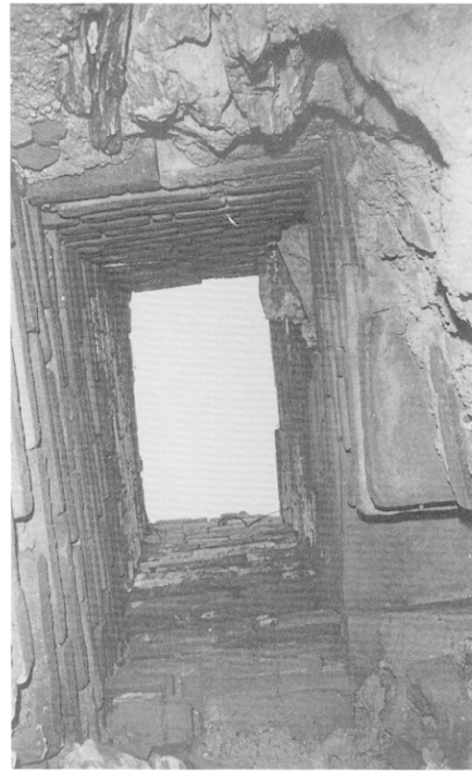
Fig. 34 — Voie II : regard R4 avant restauration.
