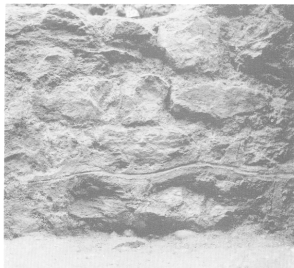
Fig. 10 — Voie II 2 : détail des joints beurrés de l'élévation du mur augustéen M9 (état 1A).
