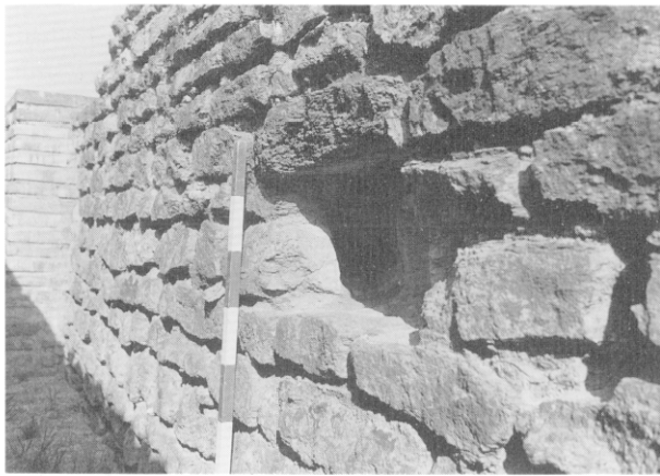
Fig. 39 — Voie II : conduit destiné au passage d'un tuyau en plomb à travers le piédroit oriental du trottoir sur drain (état 2E).
