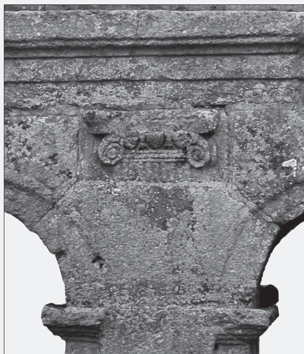
3. Porte Saint-André, vue depuis l'intérieur de la ville. Détail de la galerie supérieure : chapiteau de pilastre ionique ou composite (cliché V. Barrière).
