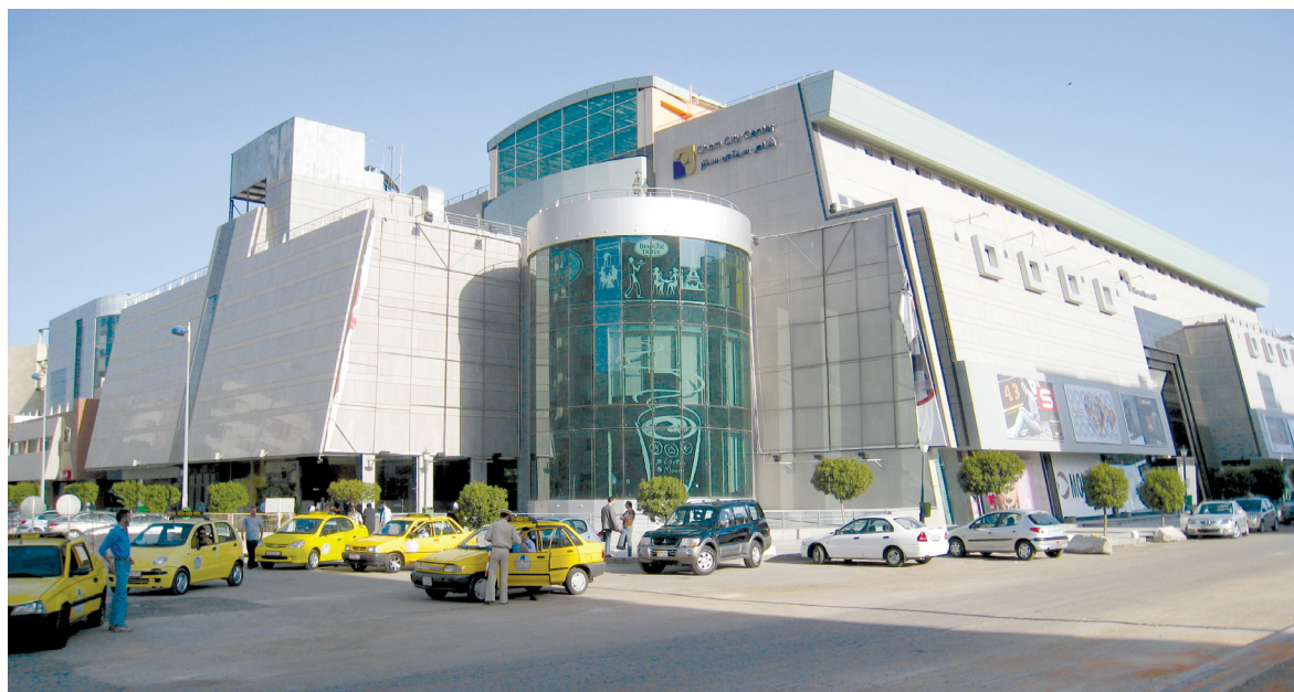
Figure 29 : Le Cham City Center de Kafer Soussé © Thierry Boissière 2006.
