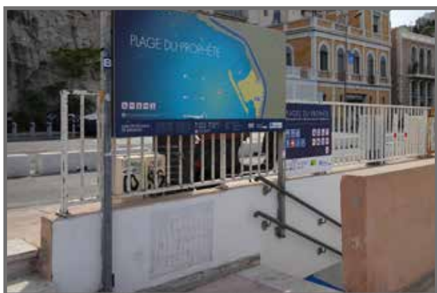
Fig. 35 - Entrée nord, vue depuis la corniche
