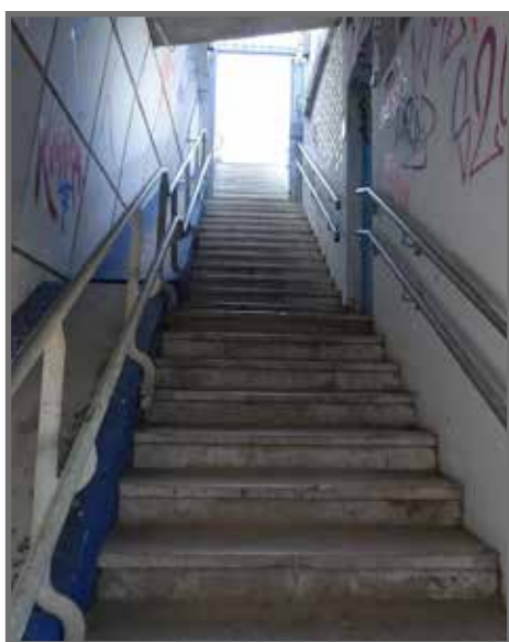
Fig. 36 - Entrée sud, vue du bas des escaliers
