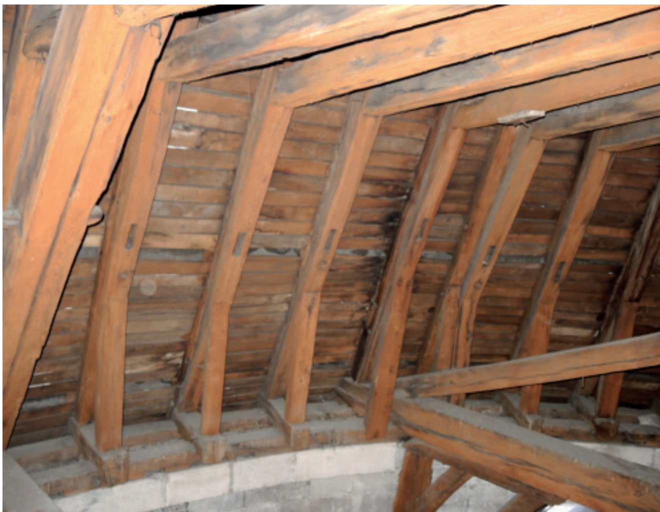
Fig. 2. Charpente de l'abside mise en place vers 1220 avec en réemploi les chevrons montrant les mortaises vides de leur première utilisation vers 1160-1170.
