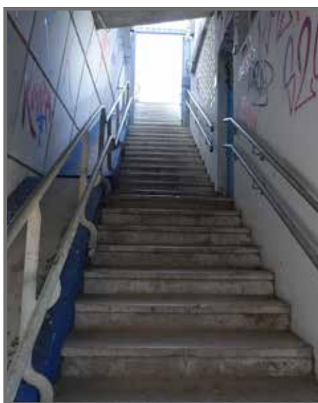
Fig. 36 - Entrée sud, vue du bas des escaliers
