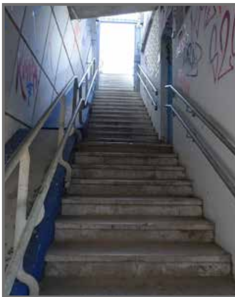
Fig. 36 - Entrée sud, vue du bas des escaliers
