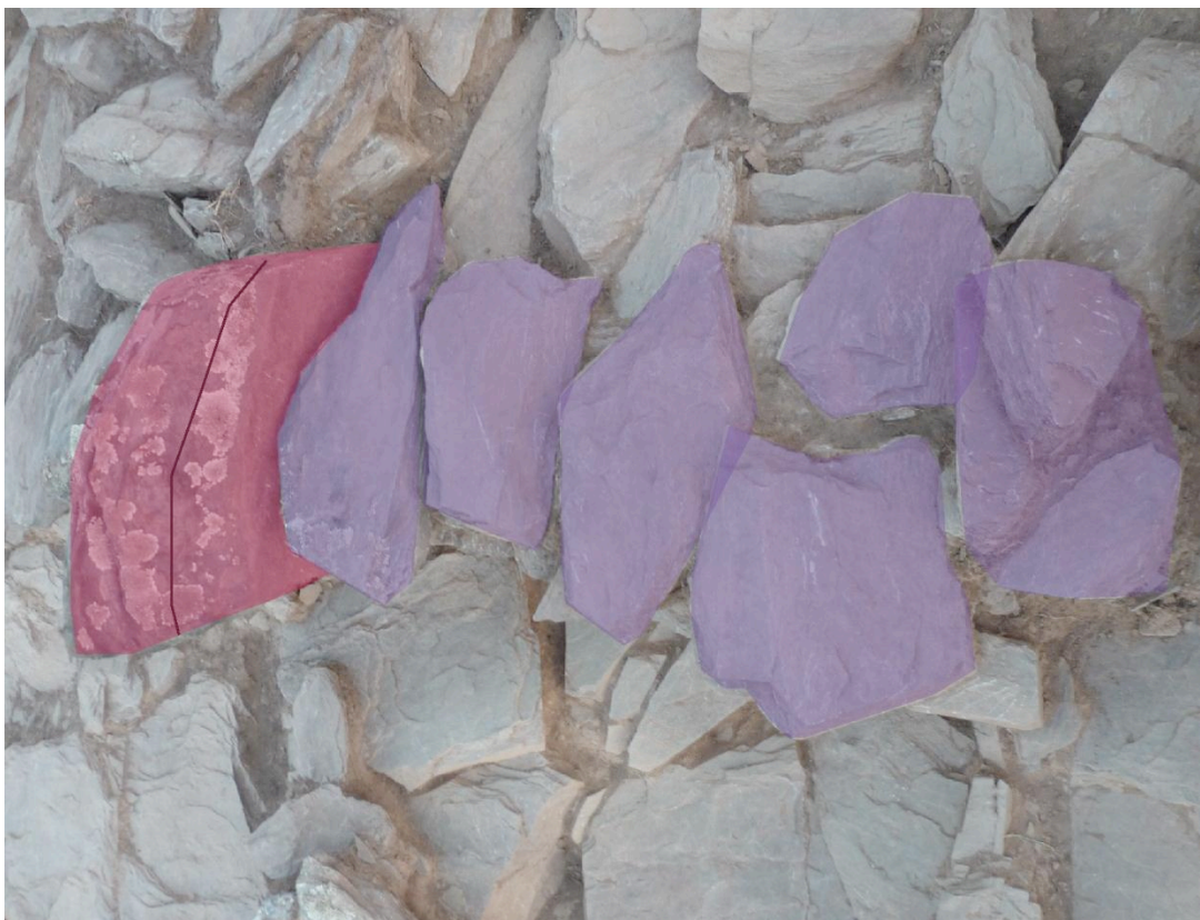
Figure 32 : Vue zénithale du mur (en violet) de la dalle rayonnante formant le parement périphérique du tumulus.
