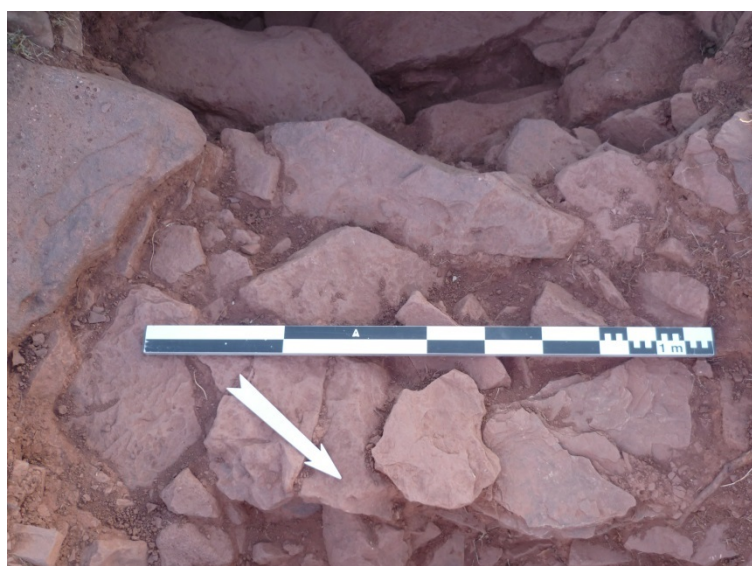
Figure 59 : Vue zénithale depuis le Nord-Est du niveau inférieur de dalles fissurées sous l'assise supérieure du renfort ST3.
