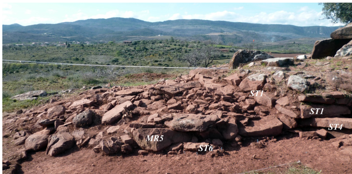
Figure 80 : Vue frontale de la paroi externe (MR5) de l'antenne Sud
