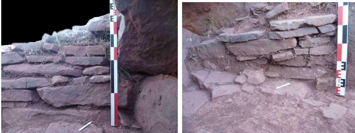
Figure 153 : Détail de l'agencement des pierres des murs latéraux du couloir. A gauche MR1 et à droite MR2.
