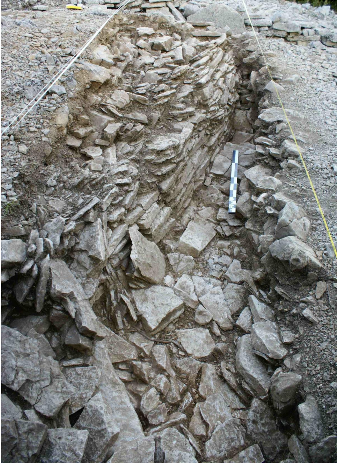
Figure 191 : Vue de la tranchée depuis l'ouest après le dégagement de ST1. Quelques dalles effondrées de cette structure sont visibles au premier plan.
