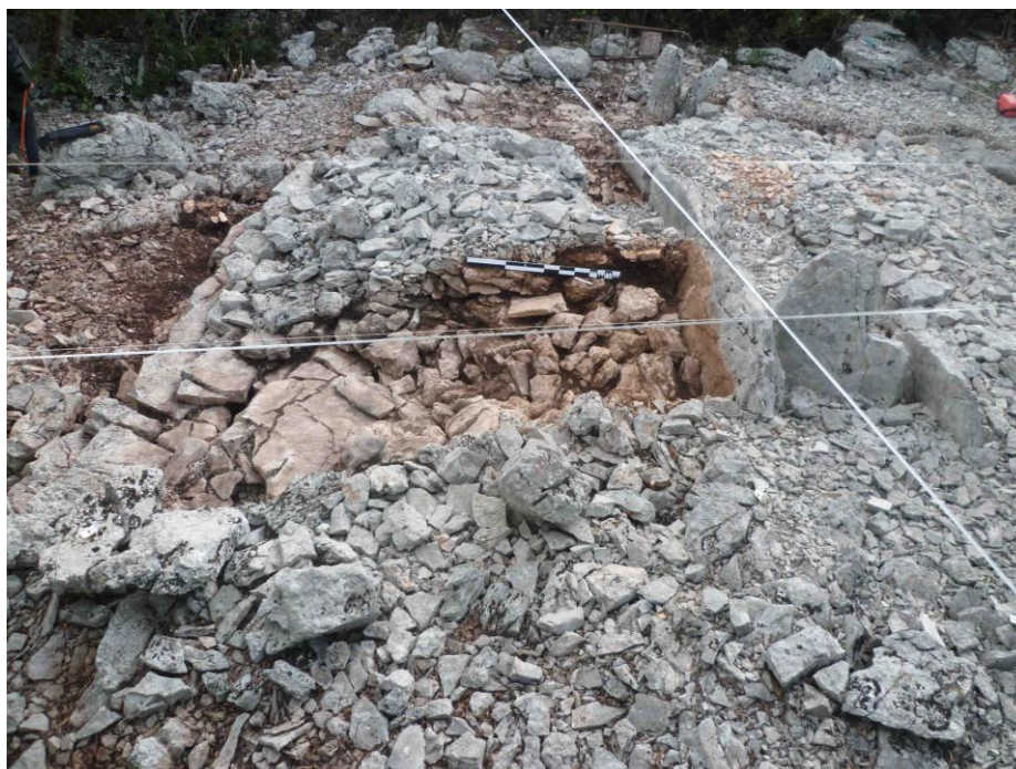
Vue de la tranchée suite à un second démontage.
