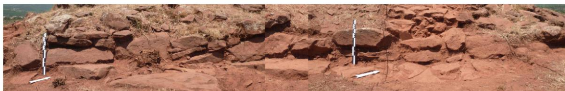
Figure 134 : Montage photo du mur parementé (ST 1) au Sud et à l'Est.
