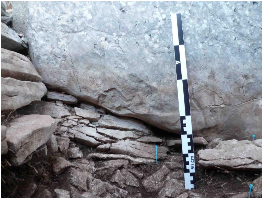
Figure 107 : Vue de la dalle délitée sous l'orthostat ouest à l'intérieur de la chambre (depuis l'est).
