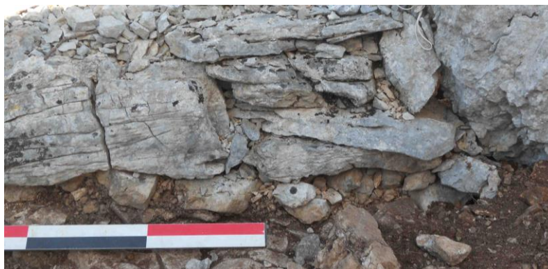
Figure 32 : Détail des assises de la paroi sud-ouest du couloir.
