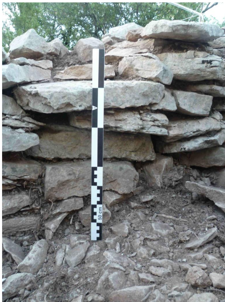
Figure 186 : Coup de sabre visible dans la paroi sud-ouest du couloir. (à gauche de l'échelle).
