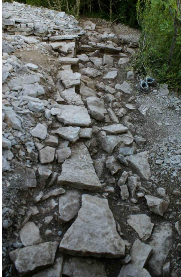
Figure 202 : La façade concave de la phase 2 (depuis l'ouest)
