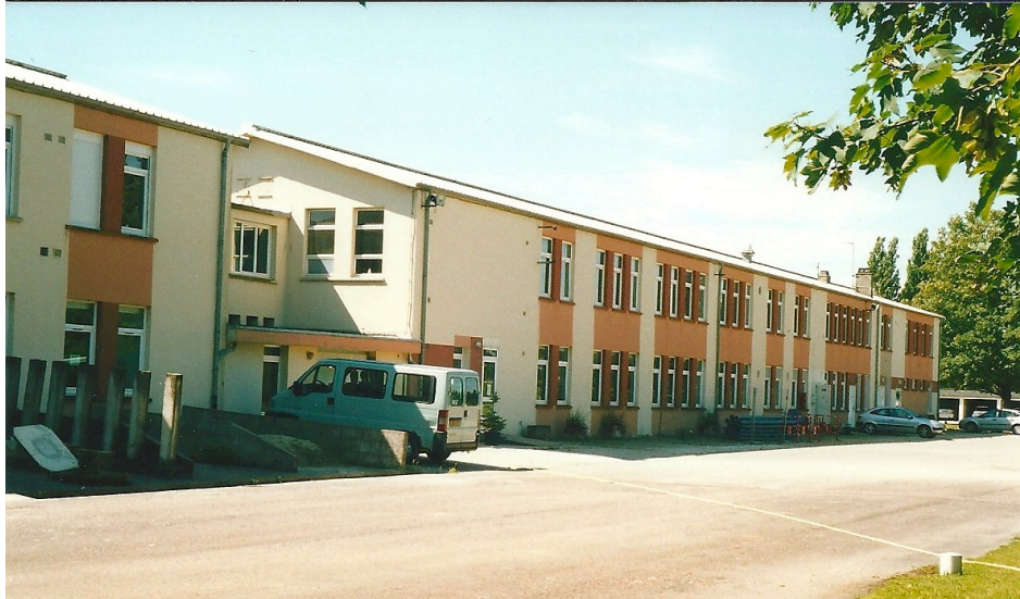
Figure 7 : l'un des bâtiments du casernement dans son aspect récent. Photographie P. Labrude, 2010.
