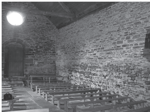
Figure 3 : Intérieur de la chapelle Saint-Gilles ; la base de l'élévation est plus ancienne au niveau des murs nord et ouest (cl. G. Le Cloirec/Inrap).
