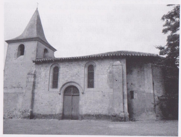
Fig. 9 : Lasserrade, église de Croute, vue générale depuis l'est. (Cliché C. Balagna)
