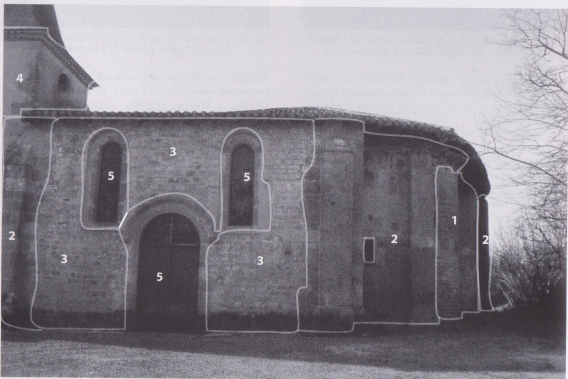
Fig. 13 : Lasserrade, église de Croute, résumé des phases de construction à partir de l'élévation orientale. 1 : Roman 1 : petits blocs de grès et calcaire disposés en lits réguliers (chevet, fin XI e s.). 2 : Roman 2 : moyen et grand appareil de grès et calcaire (contreforts, modillons, absidiole, début XII e s.). 3 : Roman 3 : petit appareil de grès et calcaire. Fenêtre romane occultée (nef, courant XII e ou XIII e s.). 4 : époque moderne : reprise d'ouvertures et du clocher en calcaire (linteaux, chaînages) et blocage. XVII e s. 5 : époque contemporaine : reprise d'ouvertures en grès et calcaire mouluré. XIX e siècle.
