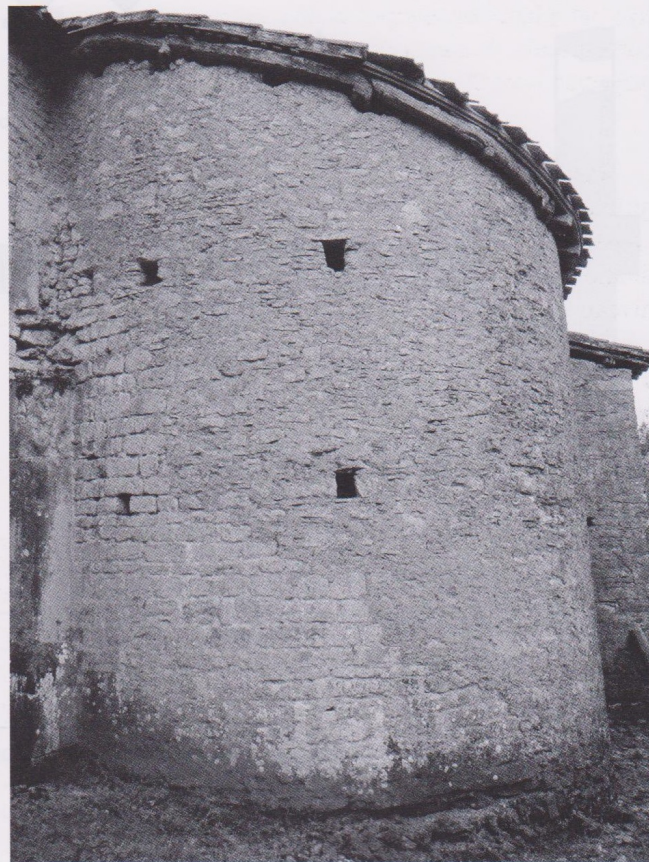
Fig. 5 : Lasserrade, église de Croute, vue extérieure de la sacristie actuelle. (Cliché C. Balagna)
