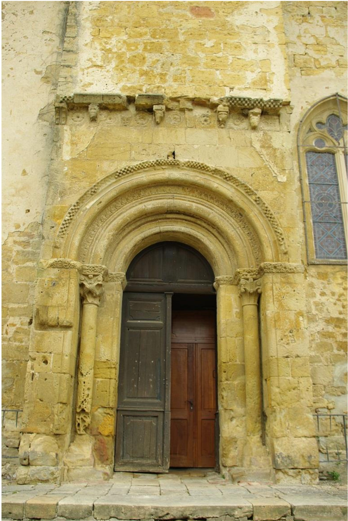
Fig. 9 : AIGNAN, église Saint-Laurent, le portail sud. Cliché C. Balagna.
