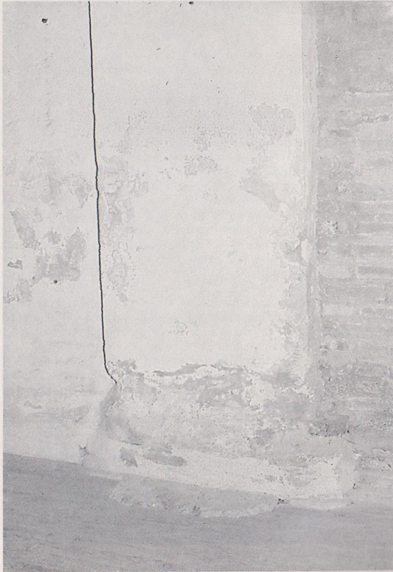
Photo 4 : Pilier nord de la nef
