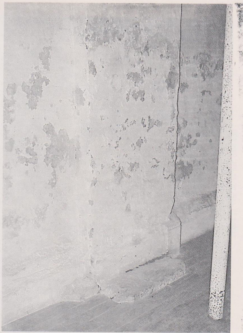
Photo 5 : Pilier sud de la nef
