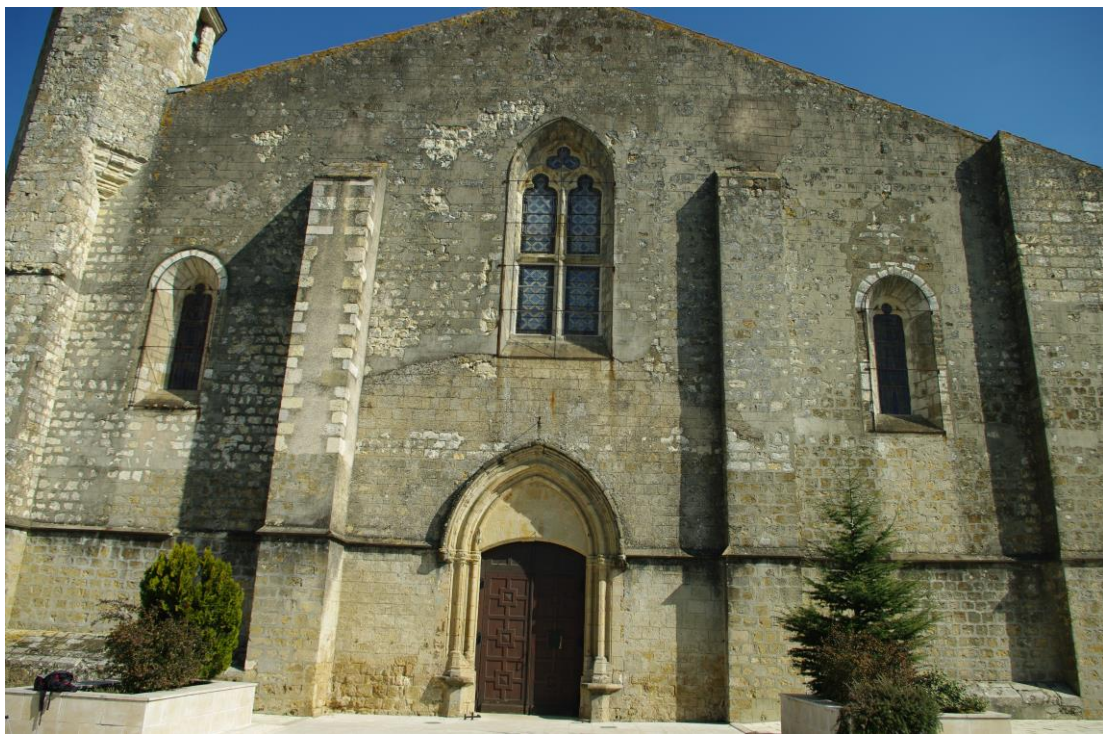
Fig. 4 : Vic-Fzensac, église Saint-Pierre, la façade occidentale.
