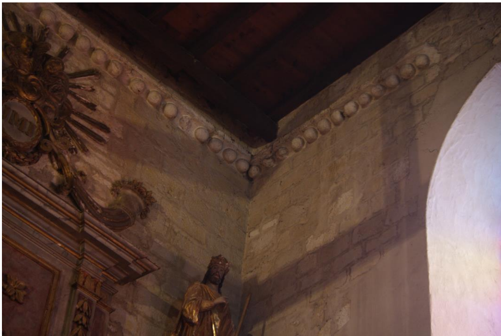
Fig. 20 : Vic-Fezensac, église Saint-Pierre, détail de l'élévation du chœur liturgique, au sud-est.
