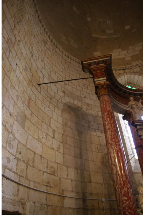
Fig. 7 : Vic-Fezensac, église Saint-Pierre, la fenêtre nord murée de l'abside.
