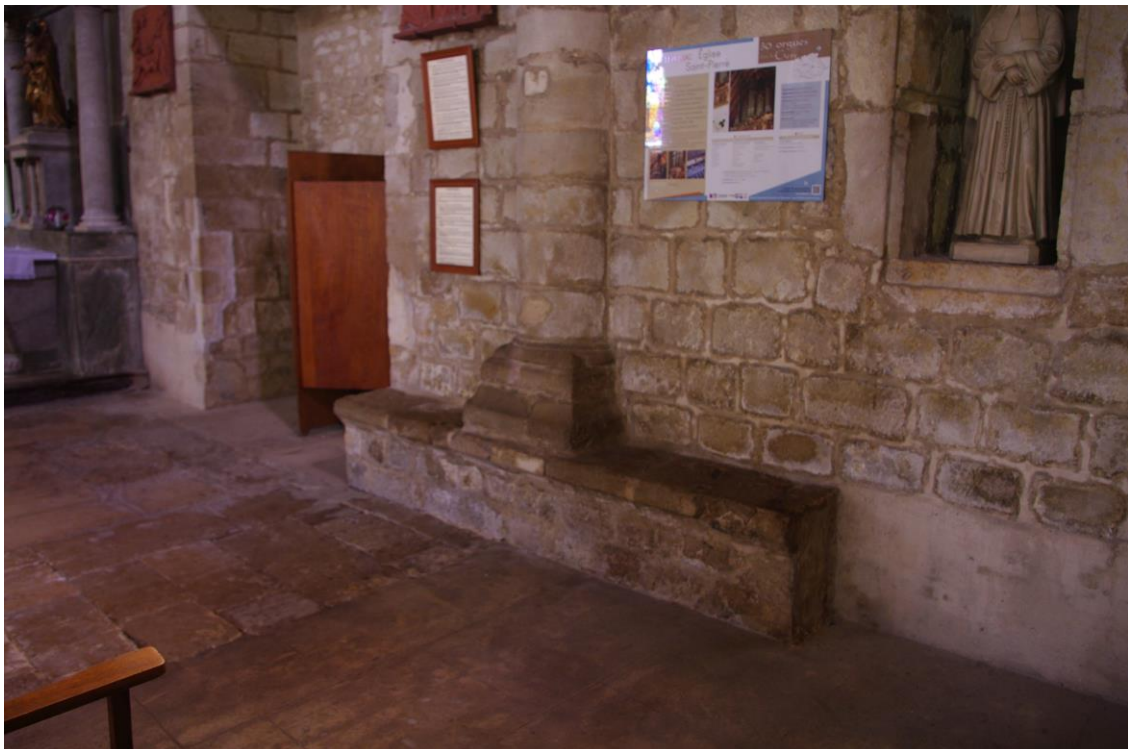
Fig. 24 : Vic-Fezensac, église Saint-Pierre, élévation du collatéral sud de la nef, détail.
