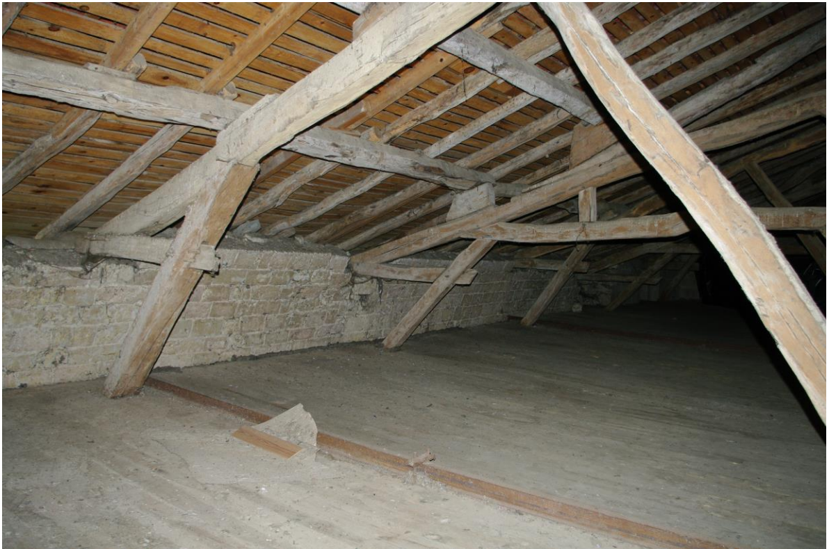
Fig. 27 : Vic-Fezensac, église Saint-Pierre, détail des parties hautes du collatéral nord, sous les combles.
