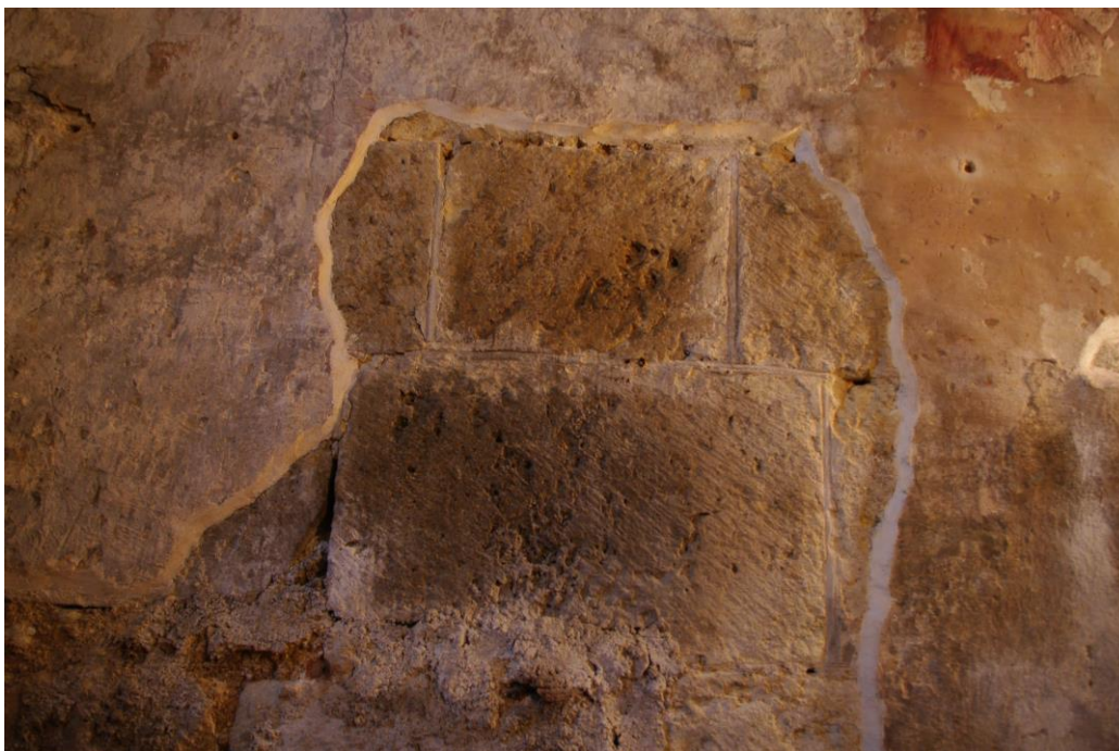
Fig. 13 : Vic-Fezensac, église Saint-Pierre, l'absidiole sud, détail des maçonneries intérieures.
