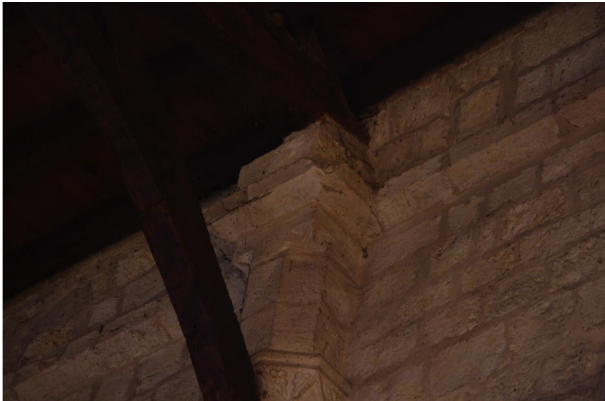
Fig. 26 : Vic-Fezensac, église Saint-Pierre, élévation du collatéral nord de la nef autour du support 3N.
