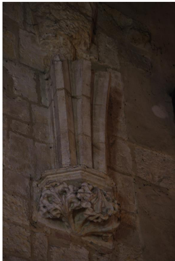
Fig. 30 : Vic-Fezensac, église Saint-Pierre, élévation du collatéral nord de la nef autour du support 2N'.
