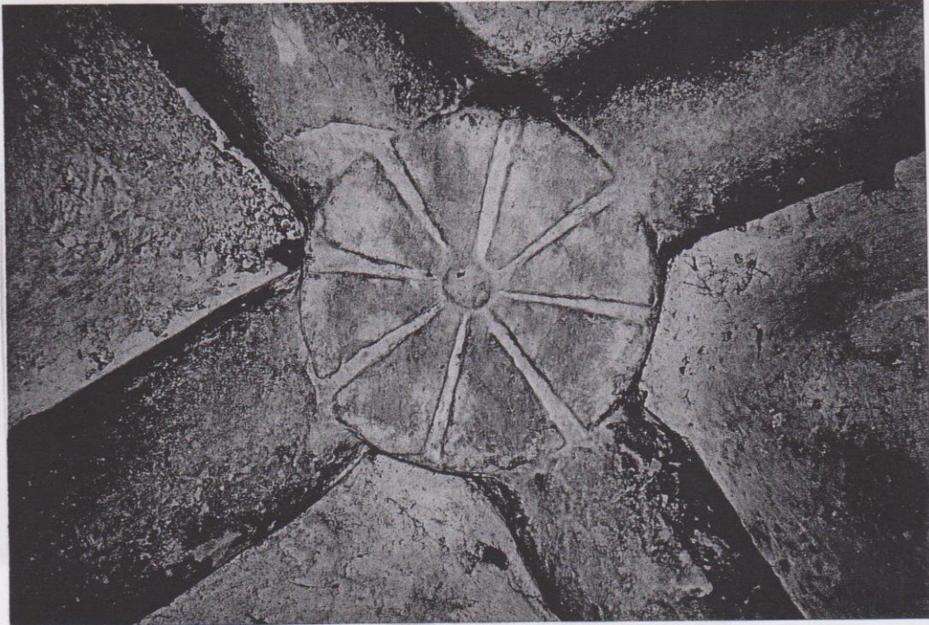
Fig. 9 : Planselve, ancienne abbaye cistercienne, détail d'une clef de voûte.
