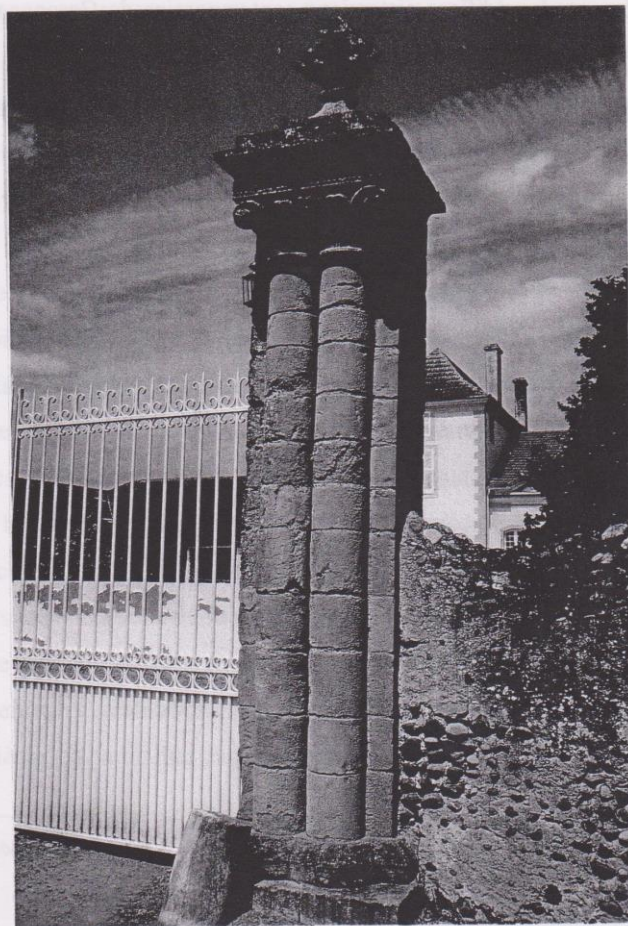
Fig. 2 : Labatut-Rivière, détail de l'élévation.
