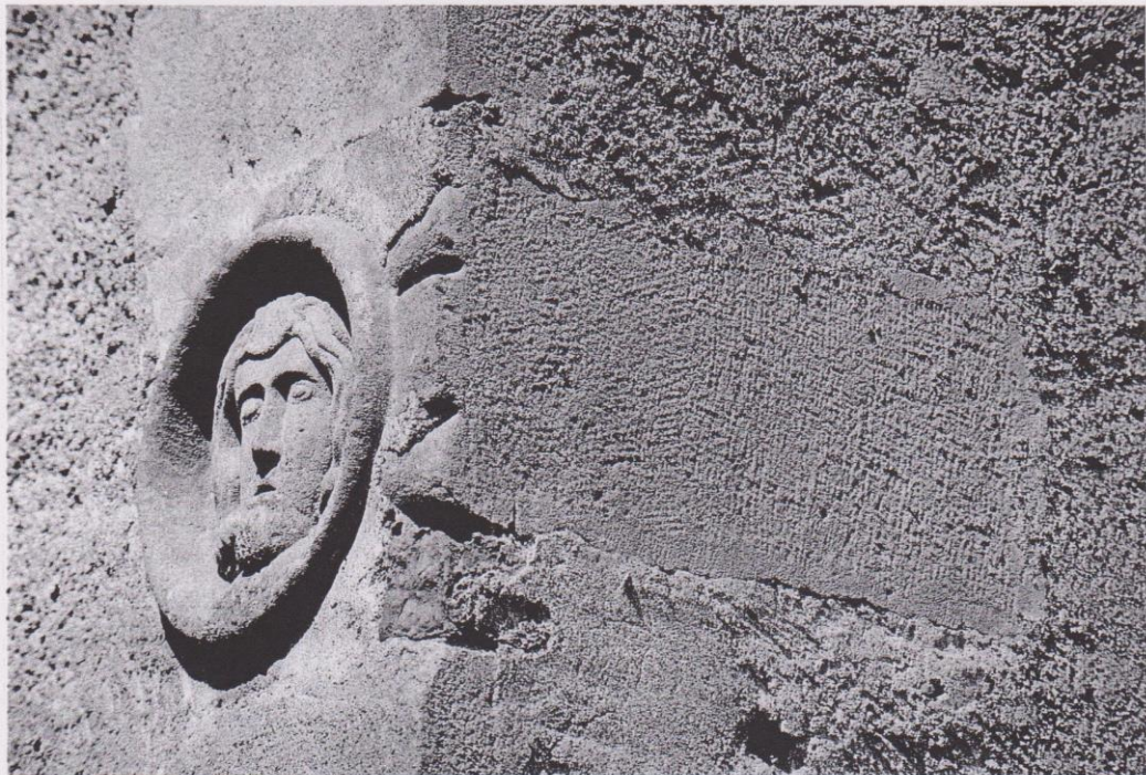
Fig. 10 : Ladevèze, vue d'ensemble de la clef de voûte.
