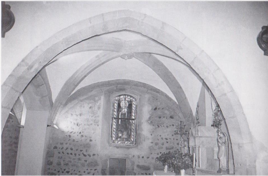
Fig. 4 - Montaut d'Astarac, église paroissiale Saint-André. La chapelle nord-est, vue intérieure (Cl. C. Balagna).
