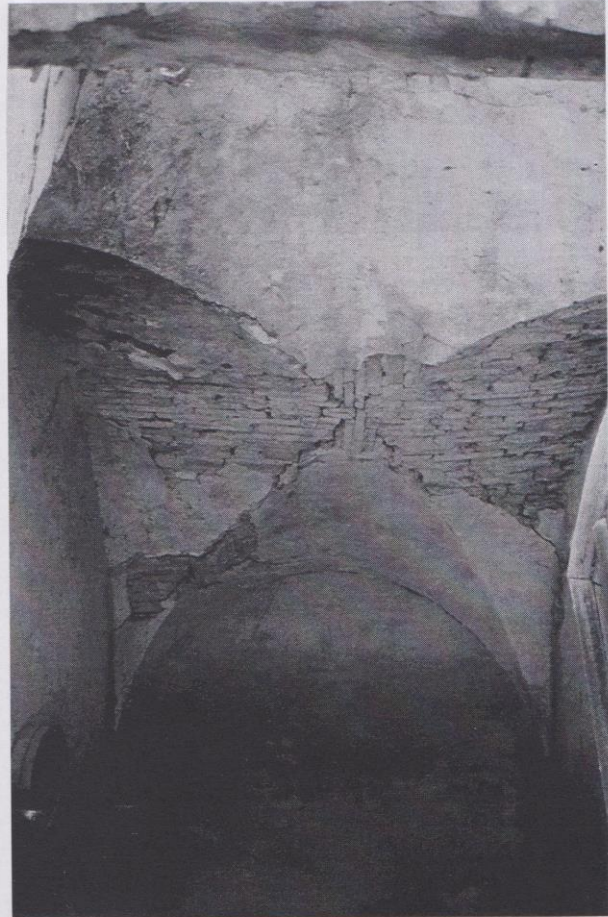
Fig. 3 : Le « parloir ». Le voûtement.
