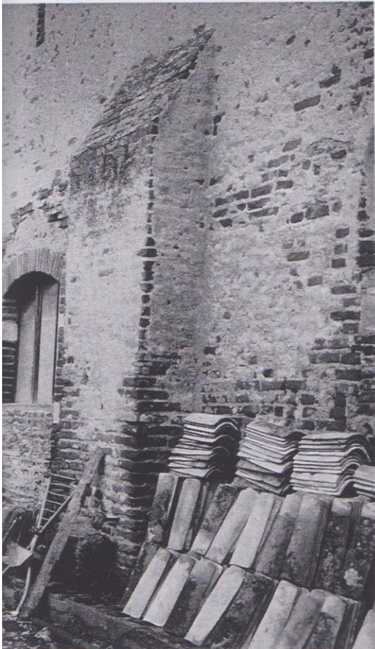
Fig. 2 : Les « écuries de l'abbé » Elévation occidentale. Détail.
