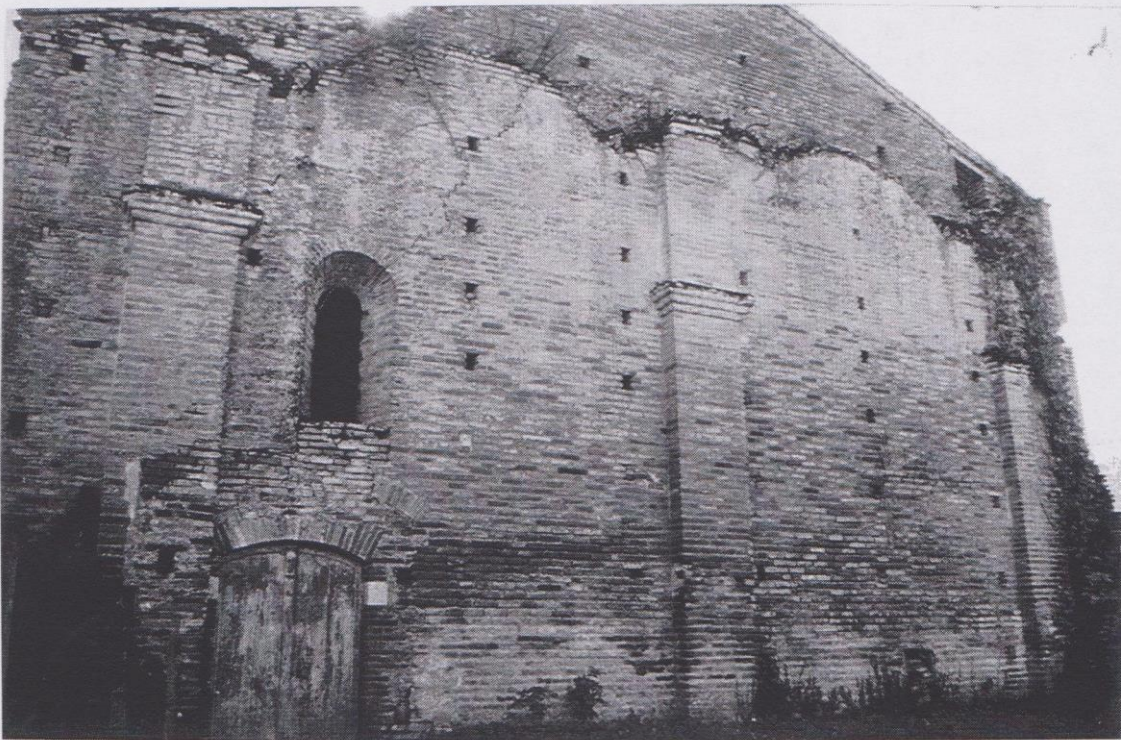
Fig.8 : Le collatéral sud de l'église abbatiale. Les deux premières travées occidentales. Elévation intérieure.
