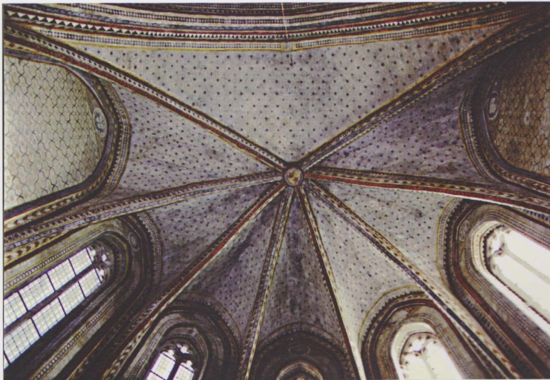
Fig 3 : La demi-travée de choeur et l'abside à pans coupés.
