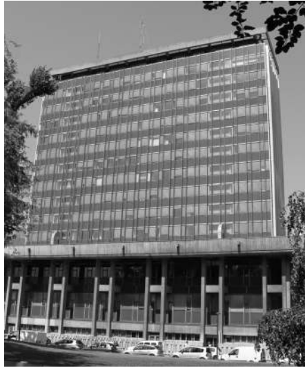
Figure 5.1. Ouvrage – vue globale
